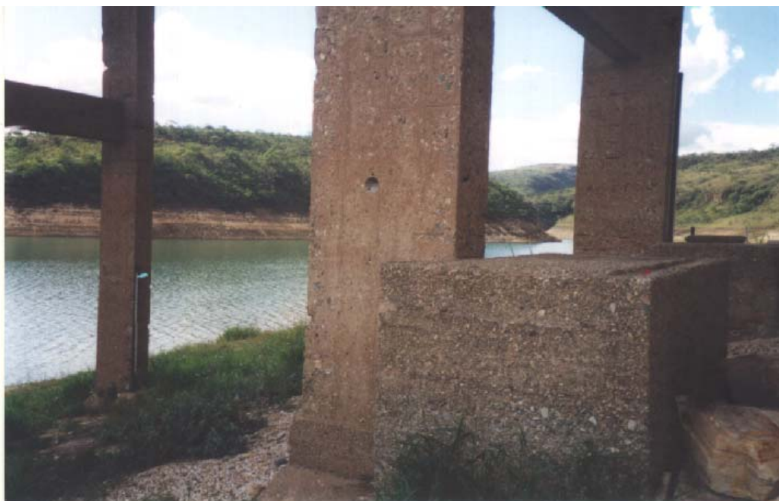
Figura 2.12 – Agregado graúdo constituído pela pedra mineira.
