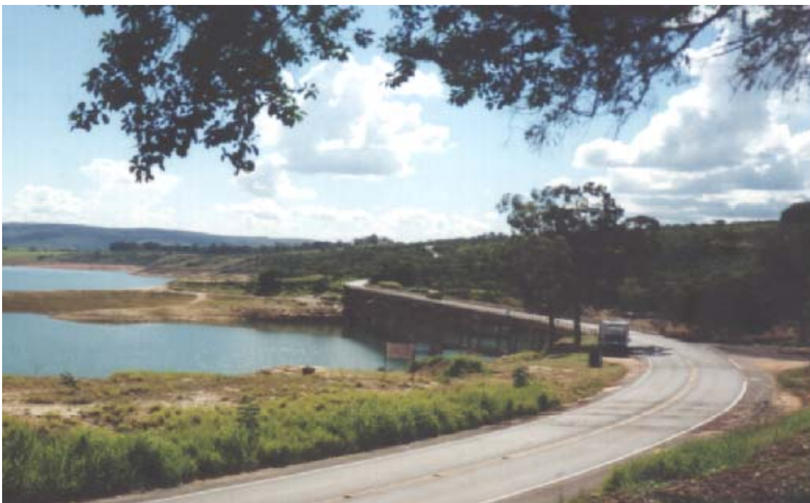
Figura 2.11 – Vista da Ponte do Rio Turvo.
