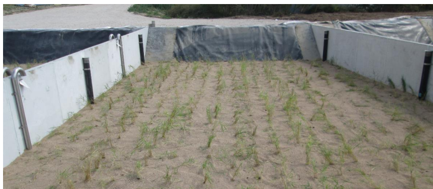
Figura 31. Filtro plantado para processamento do lodo em composto no site francês
