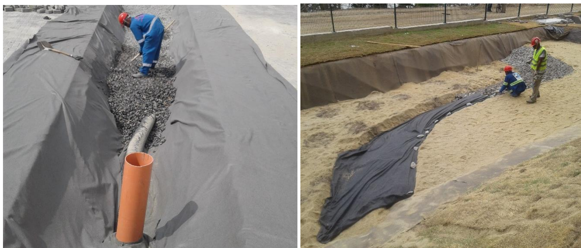
Figura 60. Colocação de pedra britada na biovaleta (esquerda) e colocação de areia na lagoa plantada (direita)
