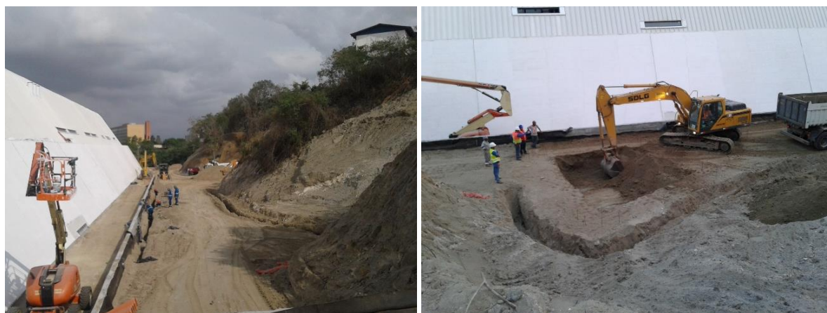
Figura 54. Início dos trabalhos de terraplenagem em agosto de 2016
