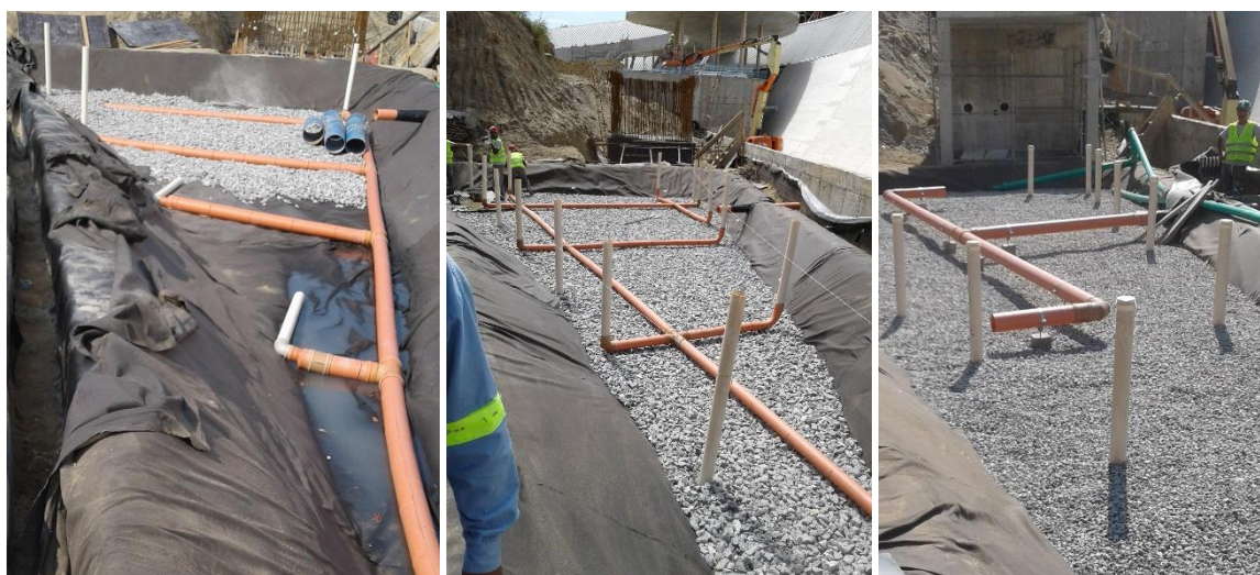
Figura 58. Instalação da rede hidráulica e material granular intercalados, outubro de 2016
