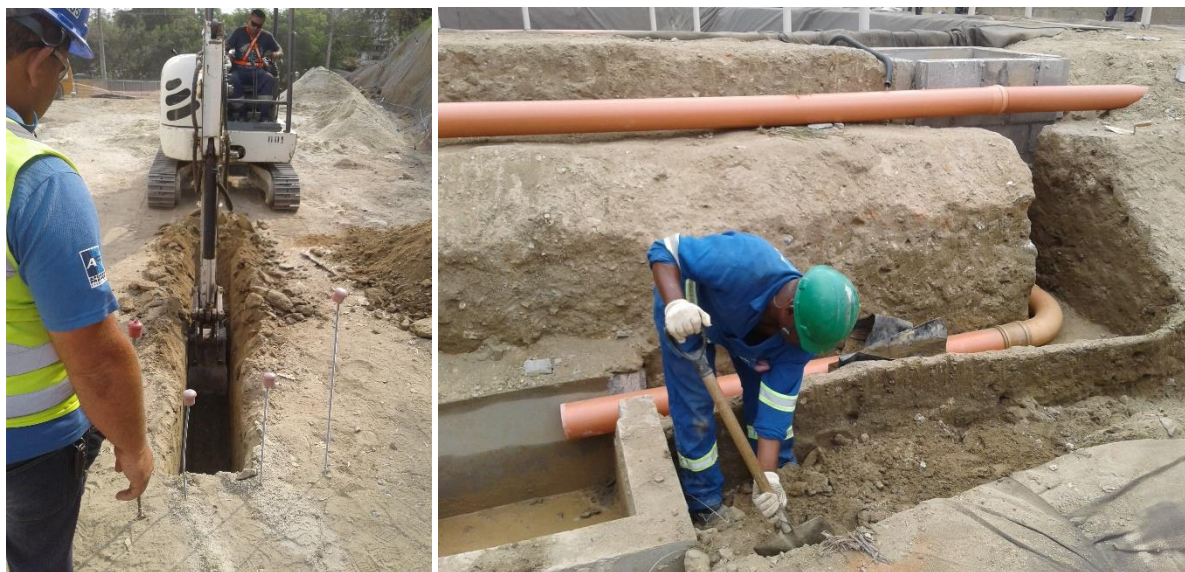
Figura 63. Escavação das valas para instalação de tubulação enterrada (acima), hidráulica externa e interface com os PVs (abaixo) em março/abril de 2016
