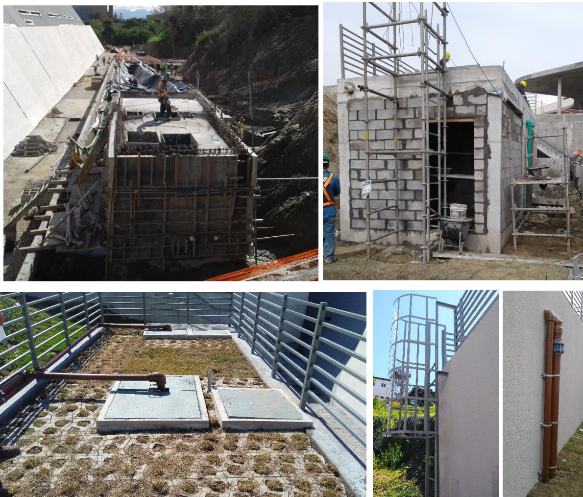
Figura 61. Construção e acabamentos do tanque de aeração em janeiro/fevereiro de 2017
