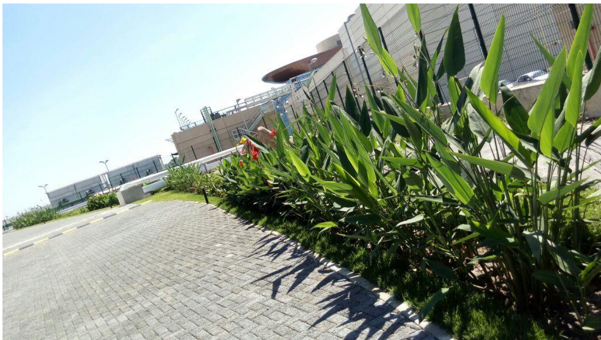
Figura 70. Biovaleta leste, margeando a rua interna de acesso ao estacionamento
