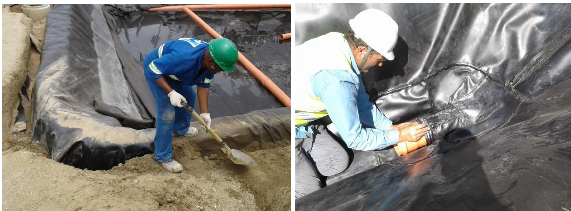
Figura 57. Reaterro da vala de fixação da impermeabilização (esquerda) e instalação de abraçadeira para montar a gola impermeabilizante no tubo, setembro de 2016
