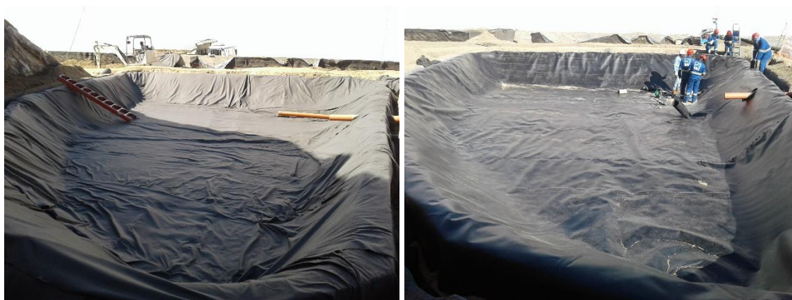
Figura 56. Instalação da manta impermeabilizante em setembro de 2016
