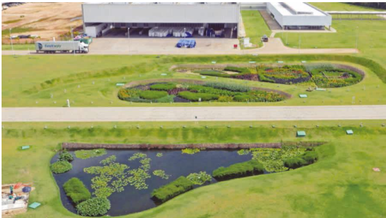
Figura 16. Jardins Filtrantes® para Tratamento de Efluentes Industriais e Sanitários - Natura Ecoparque Belém
