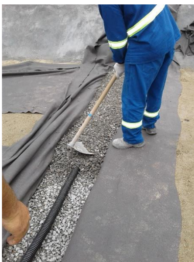
Figura 55. Colocação de pedra britada na vala do dreno testemunho em agosto de 2016
