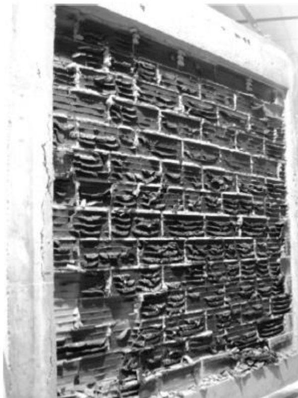
Figura 5 – Parede grossa não estrutural (Ensaio 2) após 360 minutos de exposição ao fogo, lado exposto.
