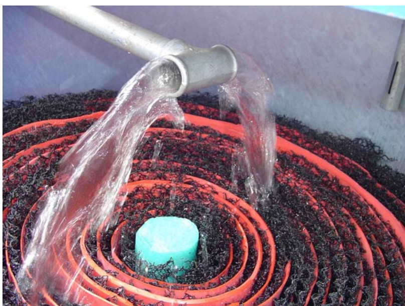
Figura 4.6: Fotografia mostrando detalhes internos da zona superior dos biofiltros:
