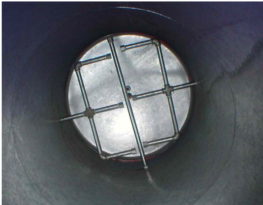
Figura 4.5: Sistema de distribuição de ar dos Biofiltros
