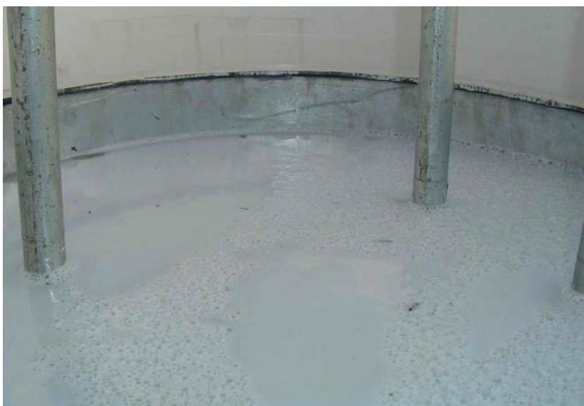
Figura 5.13 - Aspecto do lodo flotado antes da retirada por transbordamento.
