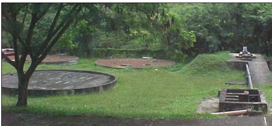
Figura 4.1: Vista geral da ETE Jd. Icaraí
