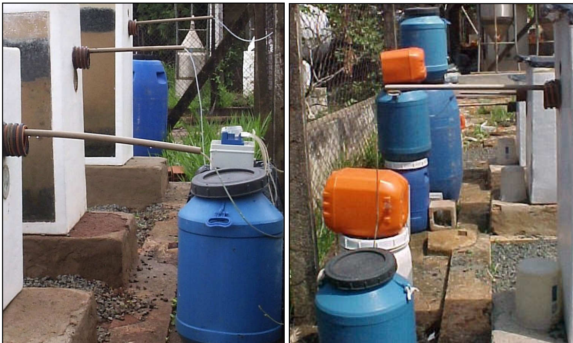
Figura 4.14: Tambores utilizados no sistema de aplicação do afluente anaeróbio
