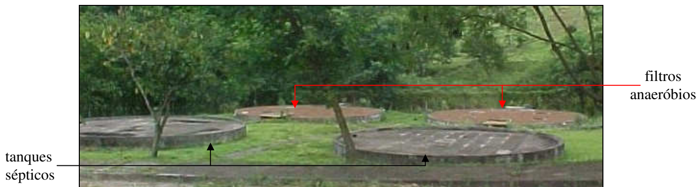
Figura 4.5: Tanque séptico e filtro anaeróbio
