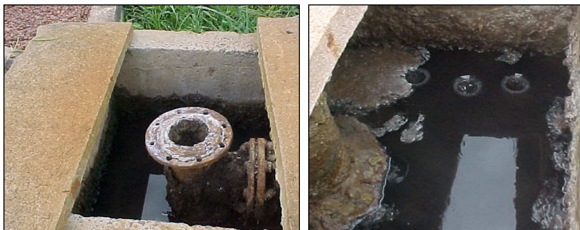
Figura 4.17: Caixa de entrada do afluente do filtro anaeróbio, local da coleta.
