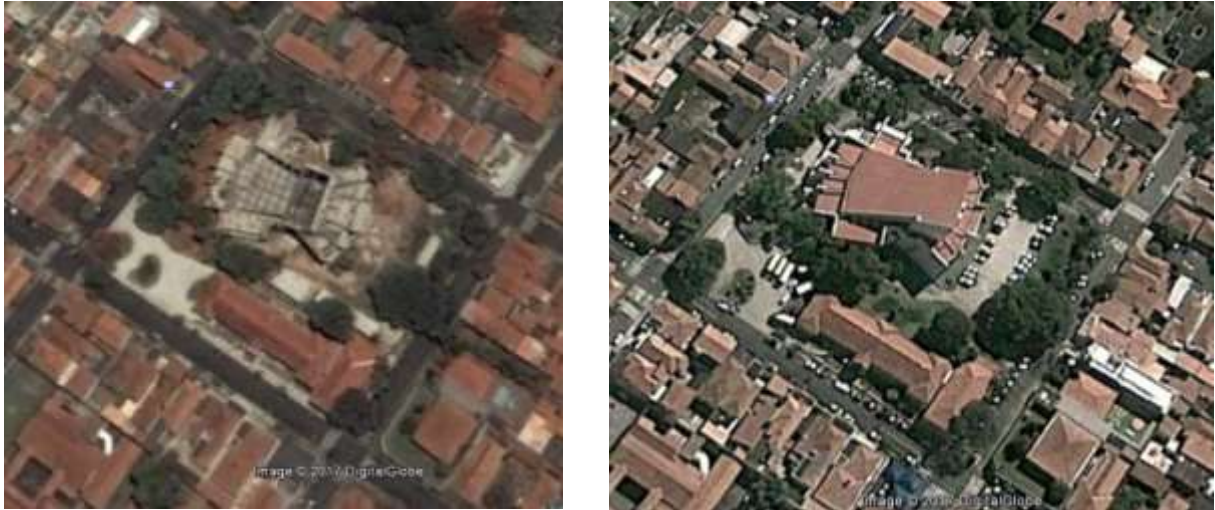
Figura 25 – Centro de Educação e Cultura Anselmo Duarte: à esquerda durante a construção em 2008 e em plena utilização em 2013.
