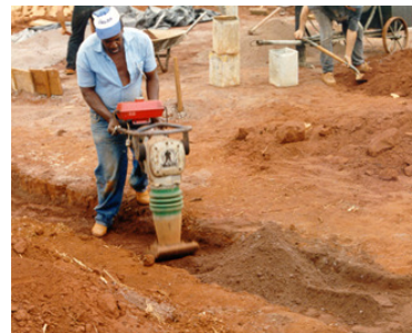
Figura 3.37: Compactação mecânica. Foto: Eduardo Salmar, 1997.
