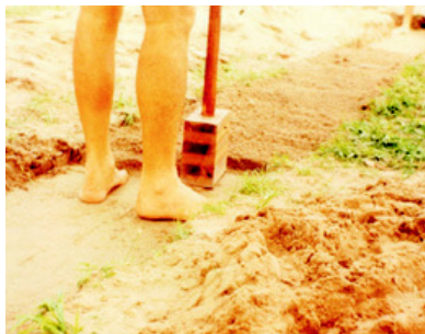
Figura 3.36: Compactação manual. Foto: Eduardo Salmar, 1988.
