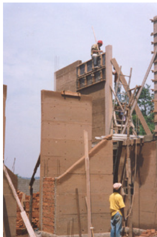
Figura 3.12: Canteiro de obras em Ribeirão Preto (SP), 1988. Foto: Eduardo Salmar, 1988.
