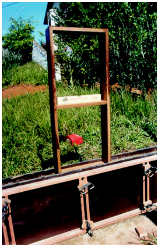
Figura 3.31: Montagem do caixilho dentro da fôrma. Foto: Eduardo Salmar, 1988.
