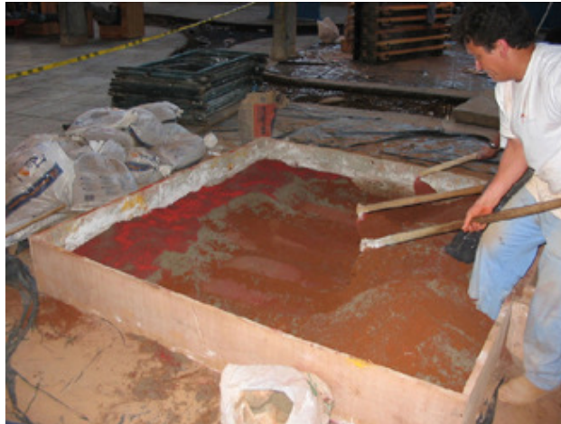
Figura 3.16: Dois operários fazendo a pré-mistura (terra + cimento). Obra no SESC-Pompéia (SP), 2003.
