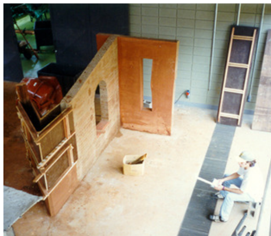
Figura 3.11: Unimep, Laboratório de Sistemas Construtivos. Santa Bárbara D'oeste, 1997.
