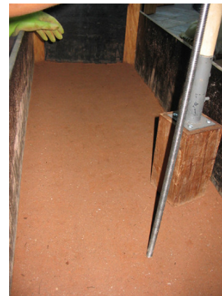
Figura 3.39: Controle de compactação. Foto: André Heise, 2002.
