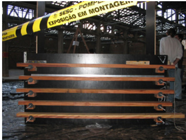
Figura 3.29: Fôrma montada (nível, prumo e alinhamento). Obra no SESC-Pompéia (SP), 2003. Foto: André Heise, 2003.
