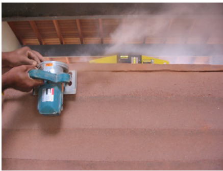
Figura 3.33: Corte do painel com uma serra elétrica. Foto: André Heise, 2002.
