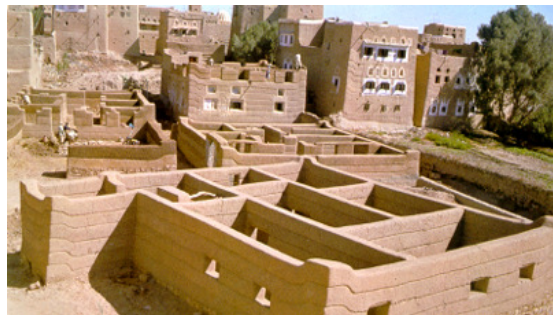
Figura 3.3: Cidade de terra crua no deserto do Yemen. Fonte: Dethier, 1981.
