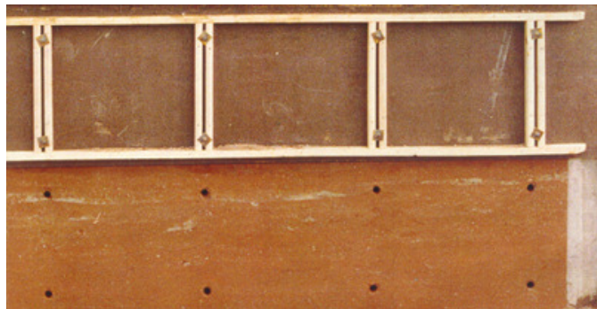
Figura 3.25: Fôrma montada acima de um painel desformado. Foto: Eduardo Salmar, 1988.
