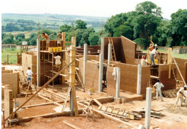
Figura 3.5: Canteiro de obras em Ribeirão Preto (SP), 1988. Foto: Eduardo Salmar, 1988.
