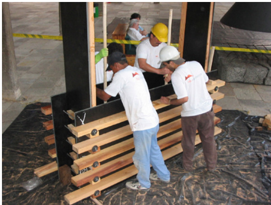
Figura 3.38: Compactação de uma formada. Foto: André Heise, 2002.
