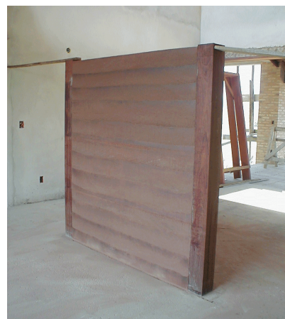
Figura 5.4: Painel de solo-cimento. Foto: André Heise, 2003.
