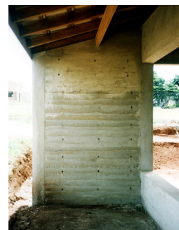
Figura 5.1: Painel de solo-cimento. Foto: André Heise, 1999.
