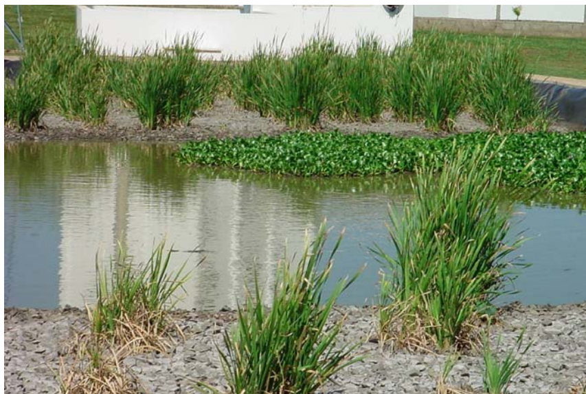
Figura 4.10 – Wetland -construído de fluxo horizontal combinado
