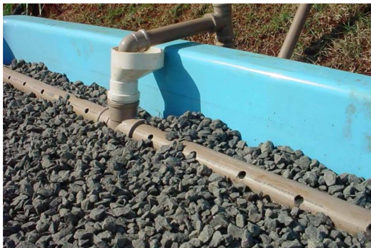
Figura 5.6 – Dispositivo de entrada implantado no sistema.
