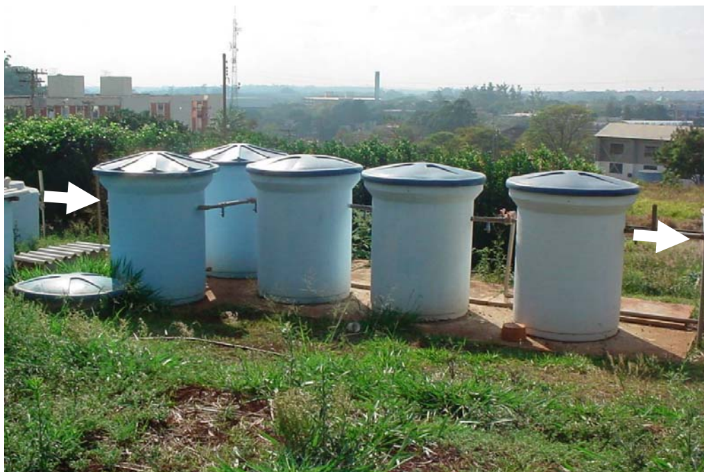
Figura 5.2 – Reator compartimentado anaeróbio
