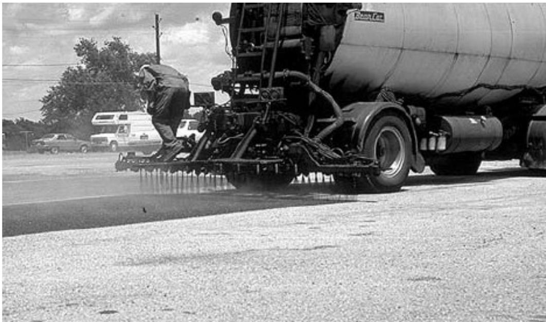
**Figura 3.6 – Distribuidores de asfalto com barra espargidora.**
