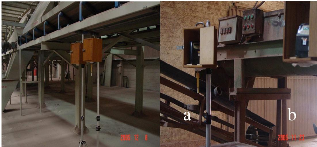
Figura 5.5 – Coleta de área de amostras de poeira, com detalhes do sistema de coleta para poeira respirável (a) e para poeira total (b).
