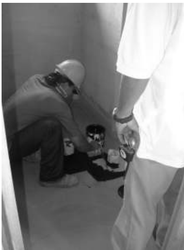
Figura 22. Detalhe de operário executando impermeabilização
