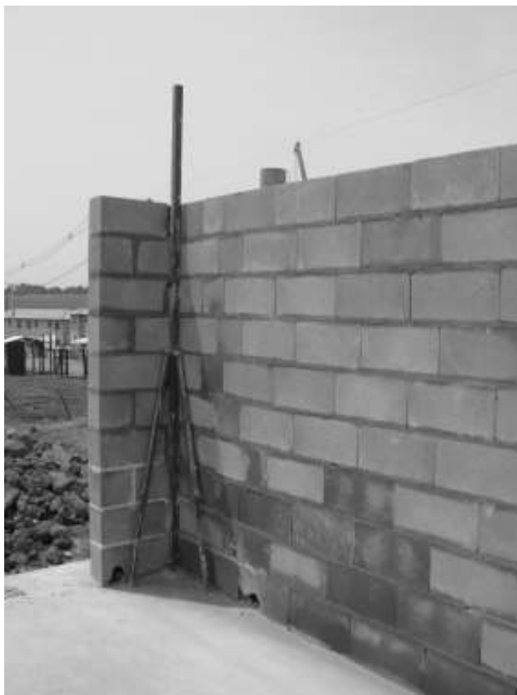
Figura 21. Detalhe do escantilhão para execução de alvenaria
