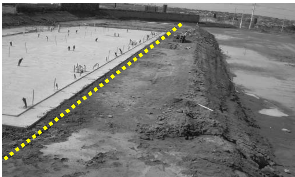
Figura 15. Detalhe de aterro e posicionamento do talude (a linha pontilhada indica a posição da crista do talude após o corte)
