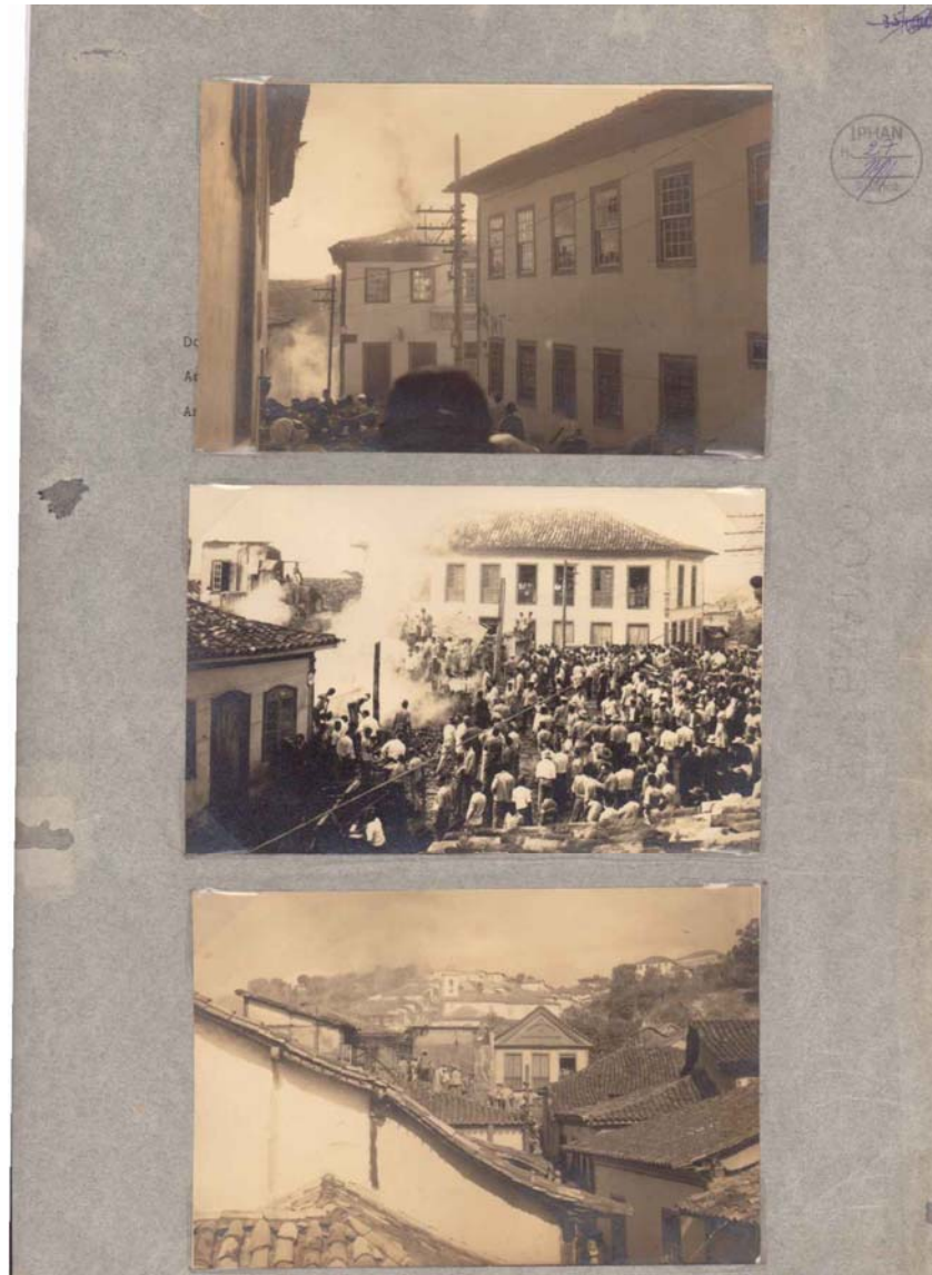
Figura 34: Incêndio ocorrido em Diamantina, 1958. Fonte: Processo de Tombamento 0064-T-38 – ACI/RJ.
