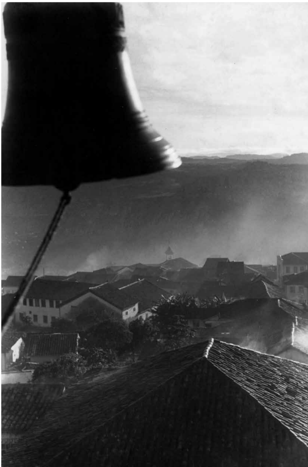
Figura 20: Telhados do conjunto de Diamantina, c. 1938. Fonte: IPHAN (2010, p.30). Autor: Erich Hess.
