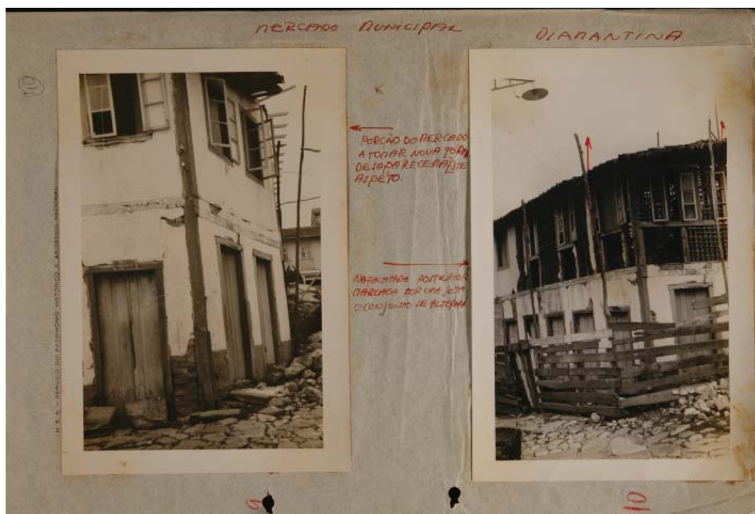
Figura 38: Volume posterior do mercado ainda em pau-a-pique durante a reforma, Diamantina, 1942. Fonte: IPHAN/ SO- Pasta 589.4 - Fotos Mercado (obra). In: Campos (2009, p.279).
