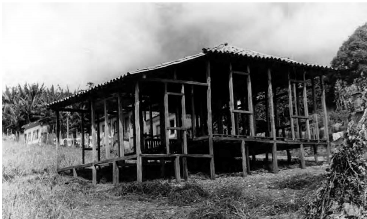
Figura 21: Casa em construção em Diamantina com estrutura de madeira, c. 1938.
