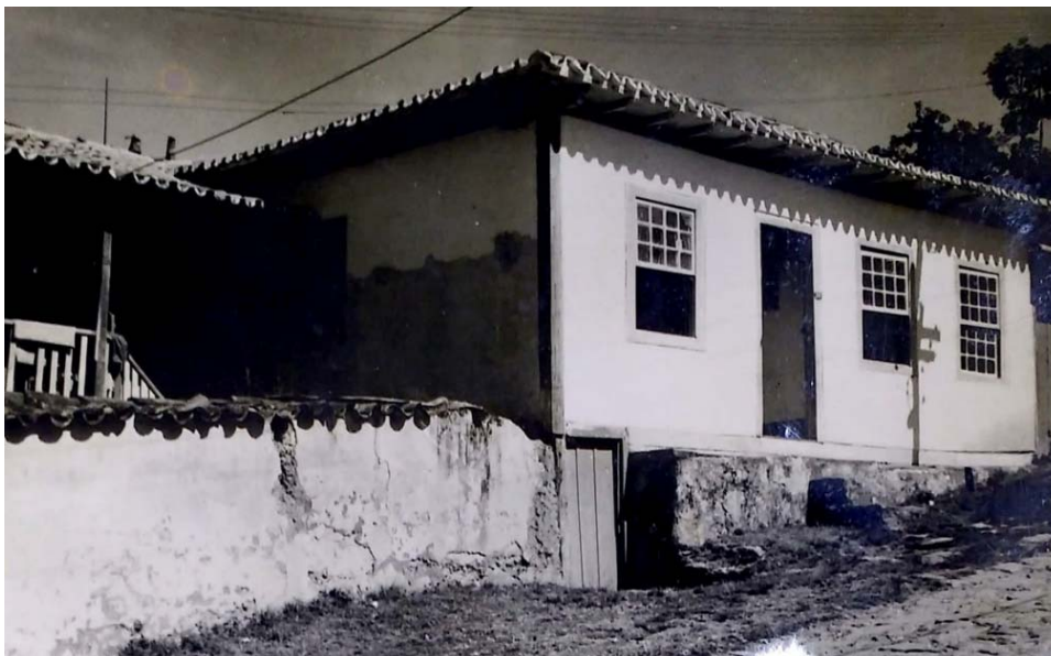
Figura 24: Casa onde Juscelino Kubitschek morou na Rua São Francisco. Levantamento realizado pelo DPHAN em 1957. Fonte: ACI/RJ-SO, Pasta 579, Cx. 198.
