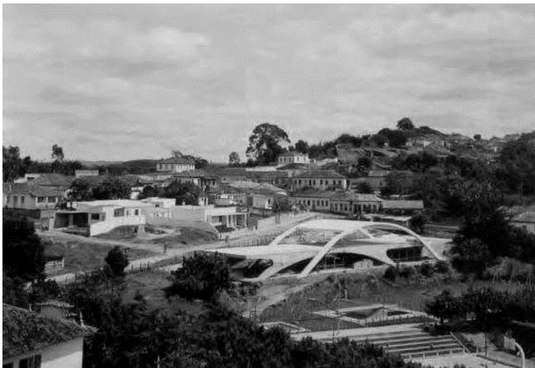
Figura 49: Sede Social em construção na Praça de Esportes. Fonte: Museu do Diamante. In: Caldas (2014, p.98) Autor: Assis Horta.
