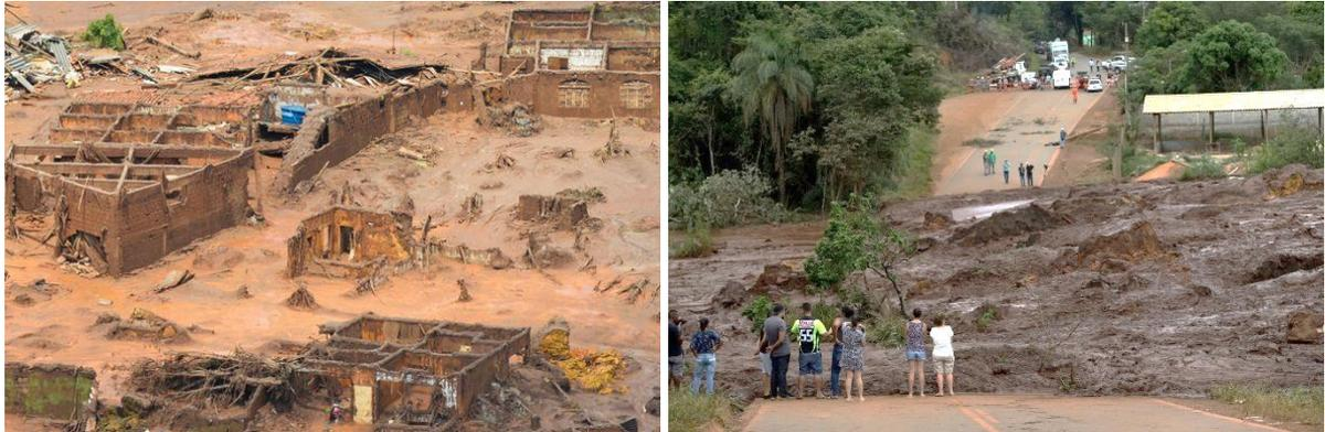
**Figura 1.** Rompimento de barragem de acumulação rejeito. Fontes: AGP (2019) - esquerda e (SBP,2019) – direita.
