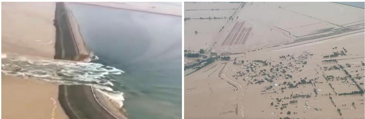
**Figura 2.** Rompimento de barragem de acumulação e água para fins de irrigação. Fonte: (CABAR, 2020).
