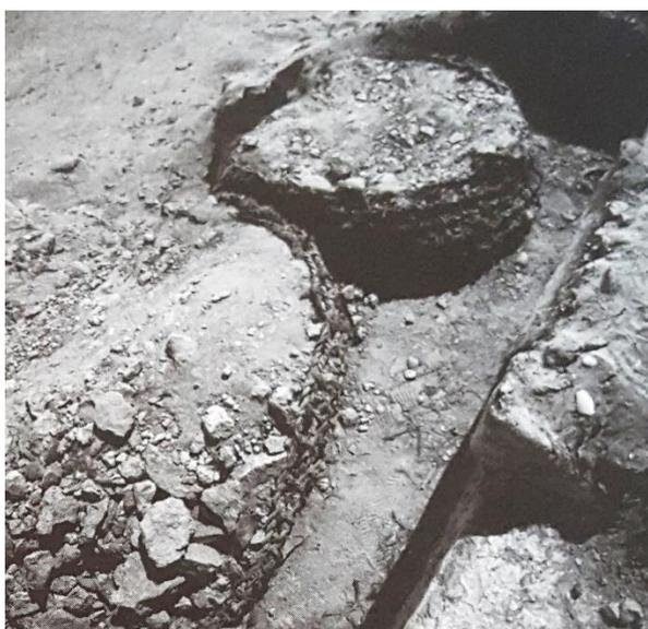
Figura 1. Gabiões executados com malhas vegetais trançadas e preenchidos com pedra, Peru. Fonte: Fracassi 2017
