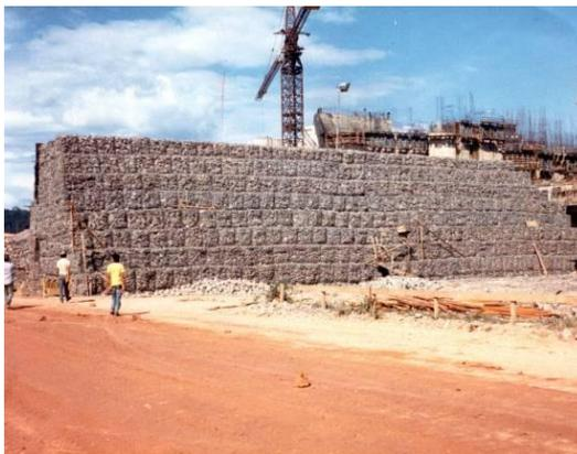
Figura 18. Execução de Barragem em gabiões, Balbina, Amazonas, Brasil. Fonte: Maccaferri do Brasil 1987
