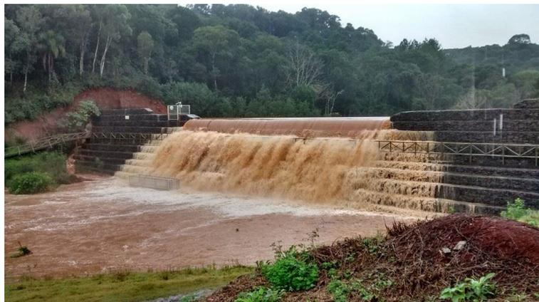
Figura 35. Barragem em gabiões com vertedor duplo trapézio, Concórdia, Santa Catarina, Brasil. Fonte: Atualfm, 2010
