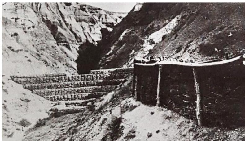
Figura 3. Barragem em Gabiões, Etiópia, 1937. Fonte: Fracassi 2017
