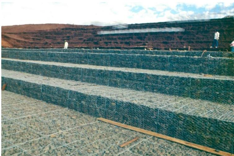
Figura 25. Barragem em Campo Grande, Mato Grosso do Sul, Brasil - Paramento em degraus. Fonte: Maccaferri do Brasil
