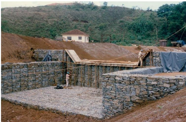
Figura 24. Barragem em Nova Lima, Minas Gerais, Brasil - Paramento vertical. Fonte: Maccaferri do Brasil
