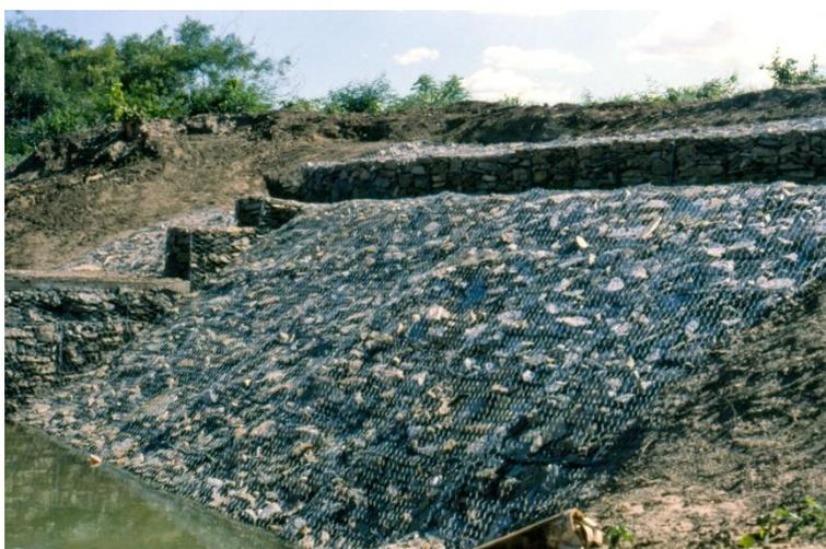
Figura 26. Barragem em Paramirim, Bahia, Brasil - Paramento inclinado. Fonte: Maccaferri do Brasil
