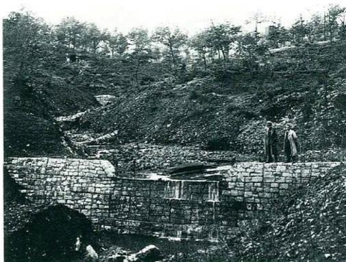
Figura 16. Barragem em Gabiões em Porretta, Bolonha, Itália, 1930. Fonte: Agostini et al., 1981
