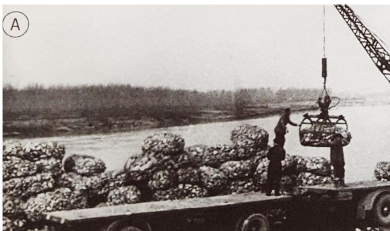
Figura 11. Início dos fechamentos das brechas do rio Pó com gabiões sacos, 1951. Fonte: Fracassi 2017
