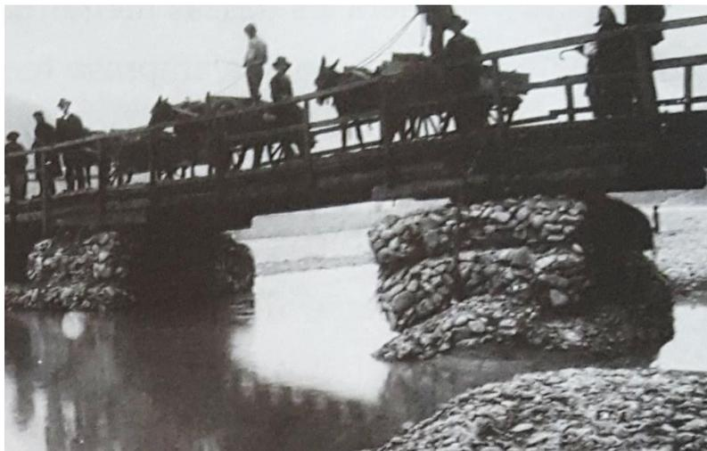
Figura 4. Apoio de ponte em Gabiões, 1910, Itália. Fonte: Fracassi 2017
