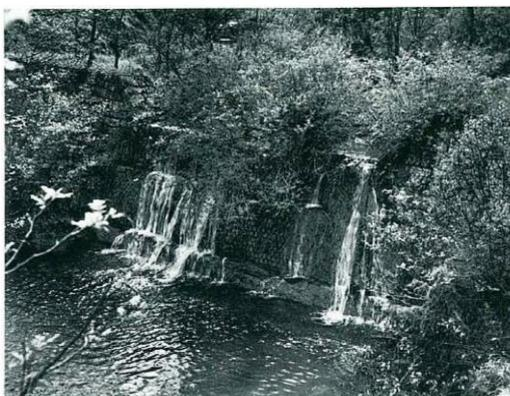
Figura 17. Barragem em Gabiões em Porretta, Bolonha, Itália, 1965. Fonte: Agostini et al., 1981
