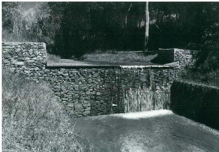
Figura 33. Barragem em gabiões com vertedor retangular, Arapongás, Paraná, Brasil.
