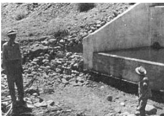
Figura 42. Erosões ocorridas no protótipo, Barragem Norte. Fonte: Peterka, 1984
