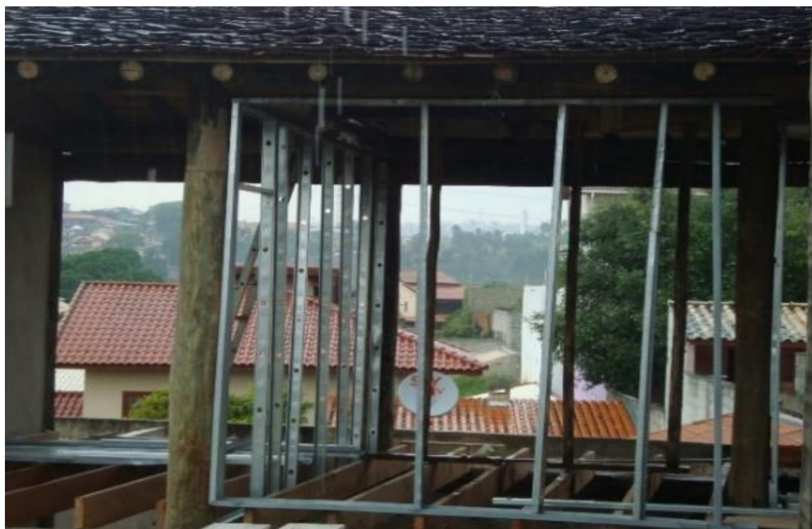
B: quadros modulares prontos para receberem placas cimentícias externamente e drywall internamente
