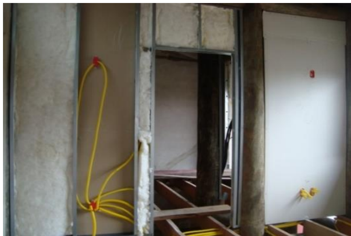
D: placas de fechamento de drywall internamente
