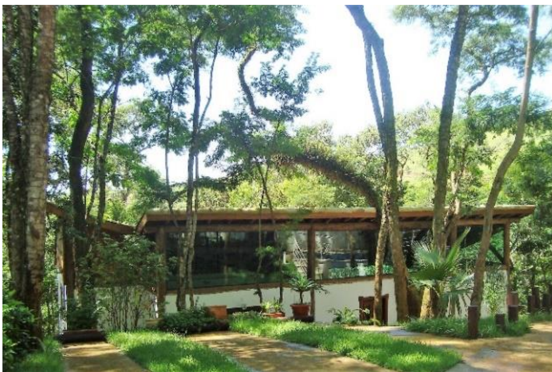
E: obra pronta, em 2010
