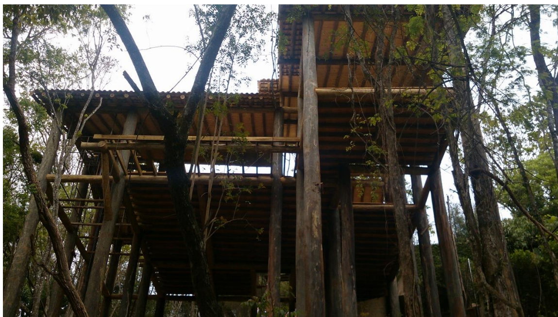
C: Estrutura e cobertura executadas, assoalho de madeira instalado (setembro de 2013)
