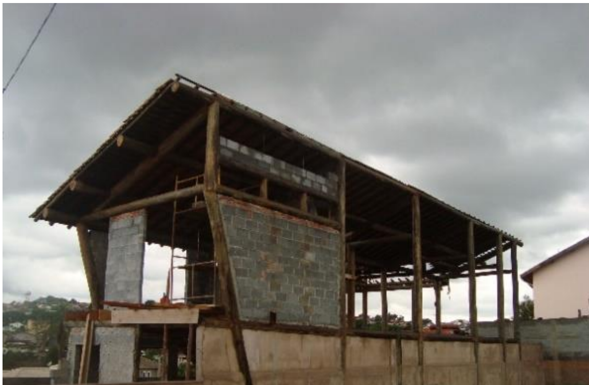
Figura 40 - Edificação da residência E (d).
