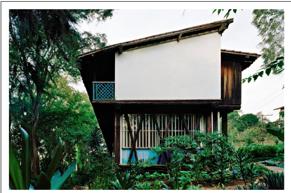
Figura 4 – Park Hotel Nova Friburgo – RJ, arquiteto Lúcio Costa, 1944 b.
