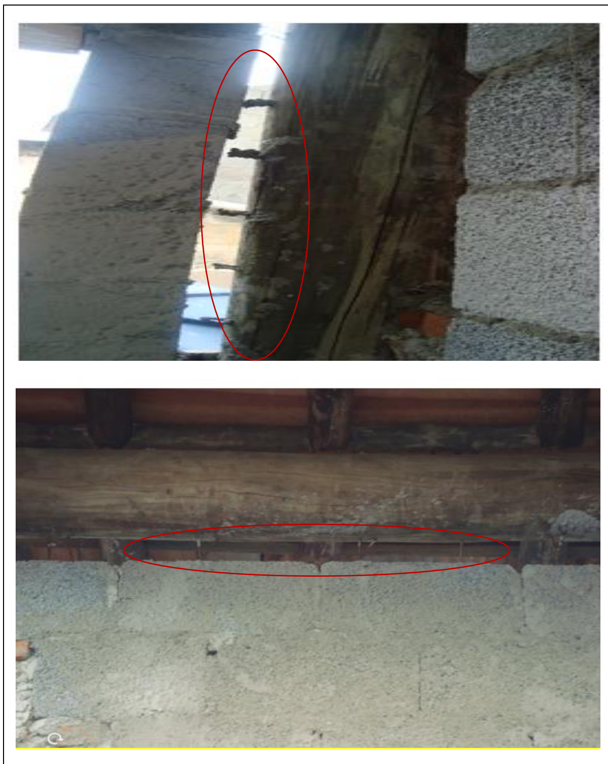
Figura 38 - Edificação da residência E (b).
