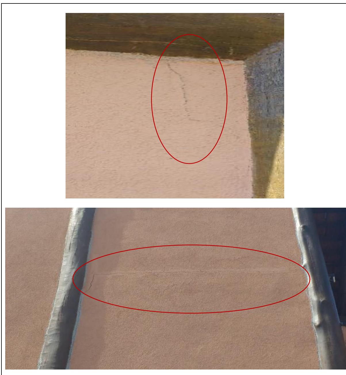
Figura 39 - Edificação da residência E (c).
