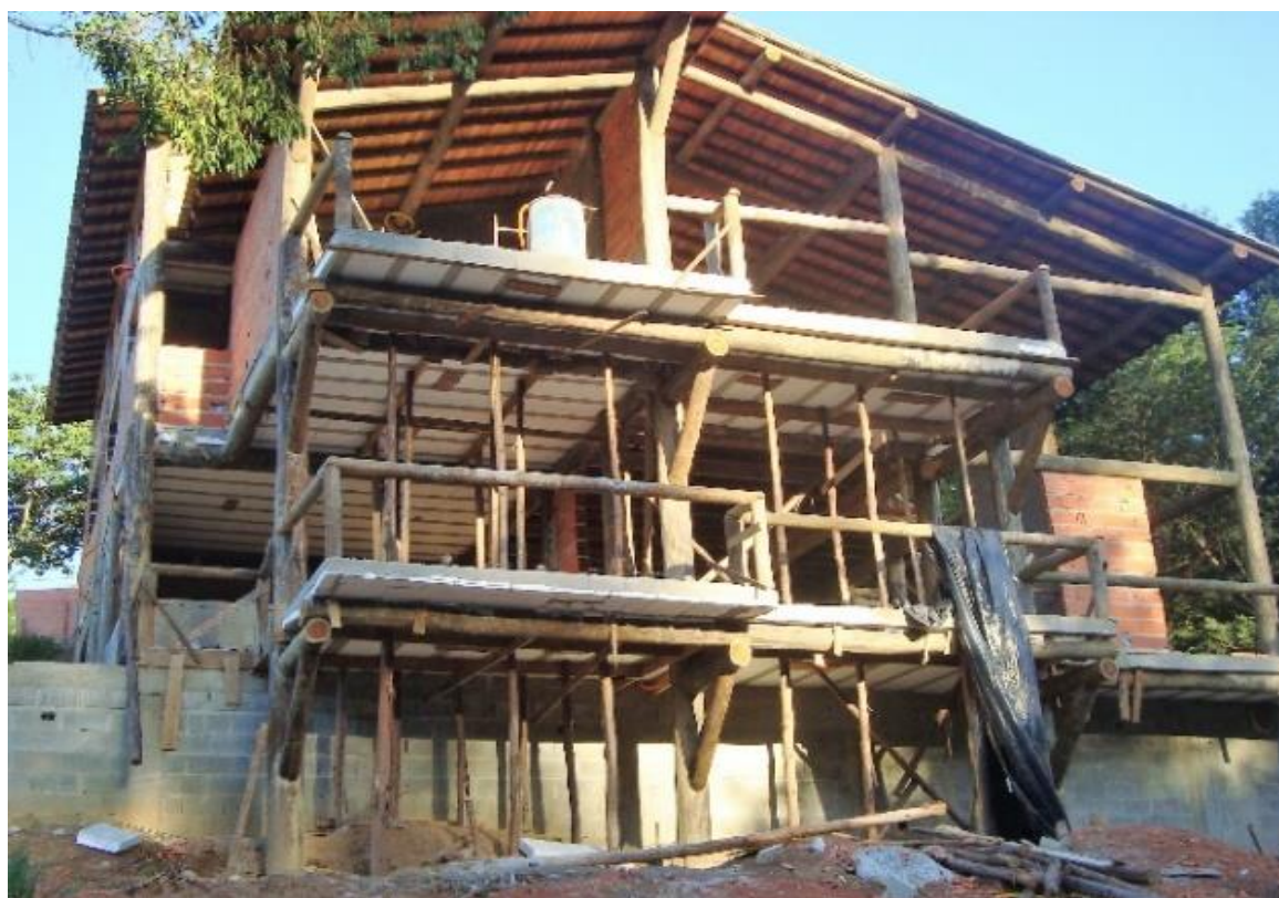
B: lajes de piso executadas recebendo as vedações em blocos cerâmicos
