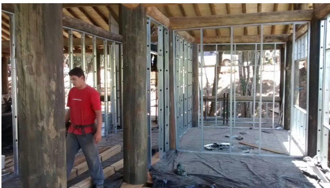
E: Vista interna, instalação dos perfis de alumínio do sistema steel frame para receber placas de drywall internamente (outubro, 2013)
