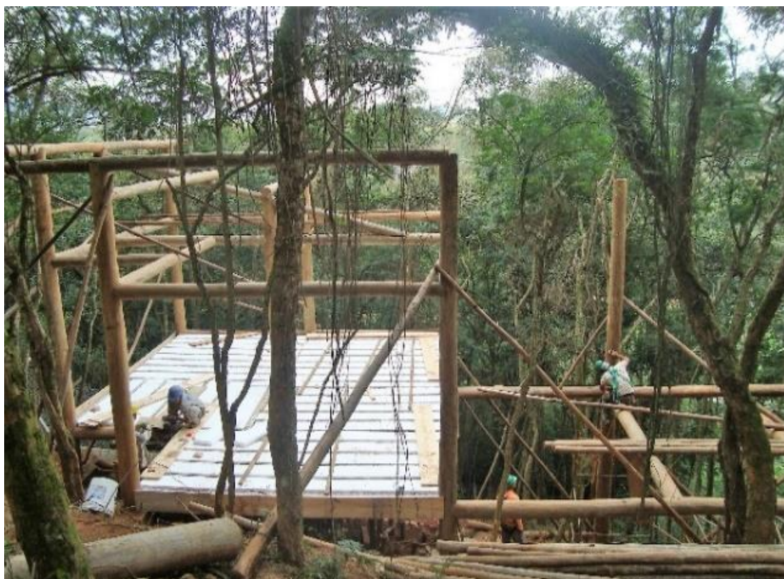
A: Laje H8 em execução (agosto de 2008)
