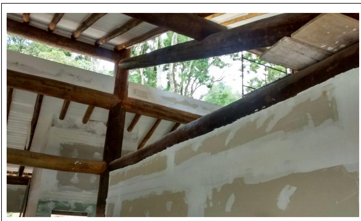
Figura 17 – Obra em andamento em 2013.
