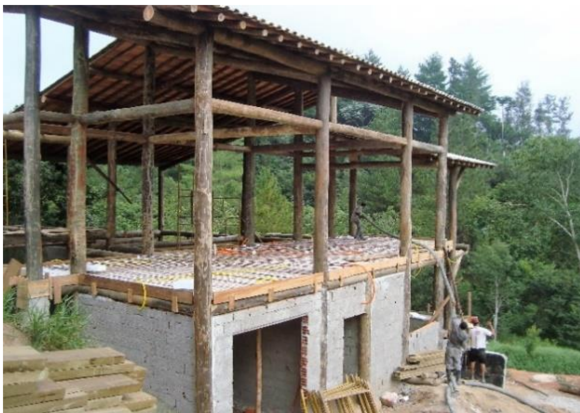
A: estrutura pilar x viga em madeira e laje em execução em 2013
