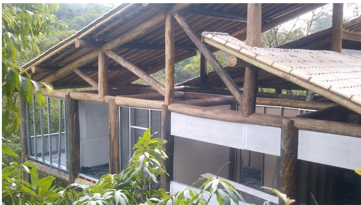
F: Placas cimentícias sendo instaladas externamente (outubro, 2013)
