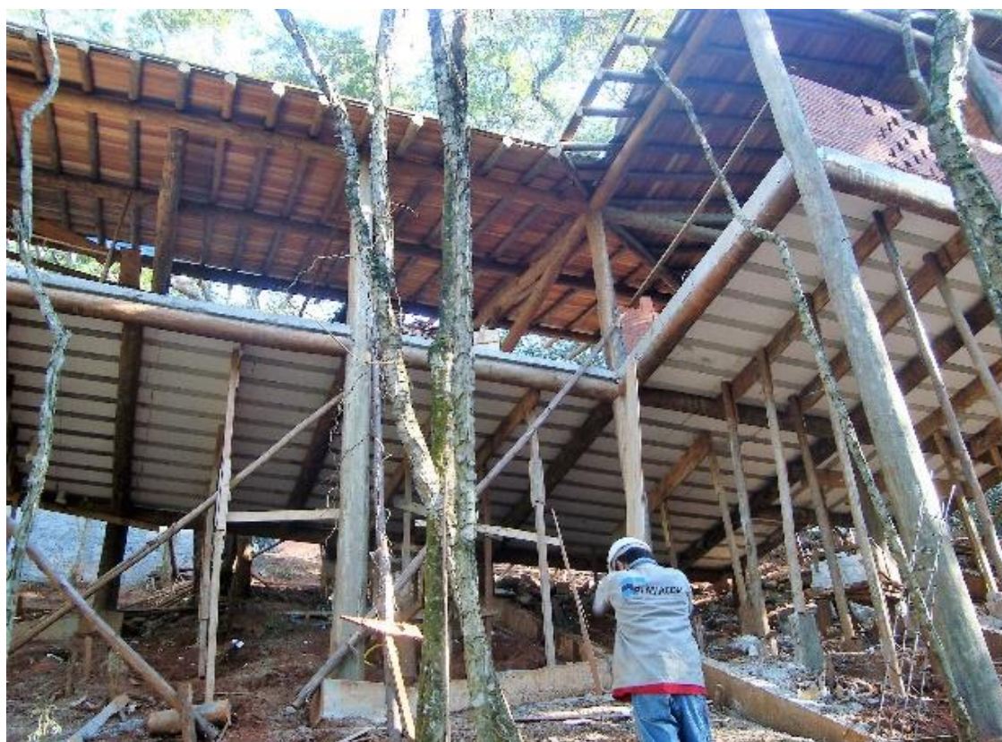
B: Vista inferior da execução da laje H8 e vedações de blocos cerâmicos 19x29x39cm
