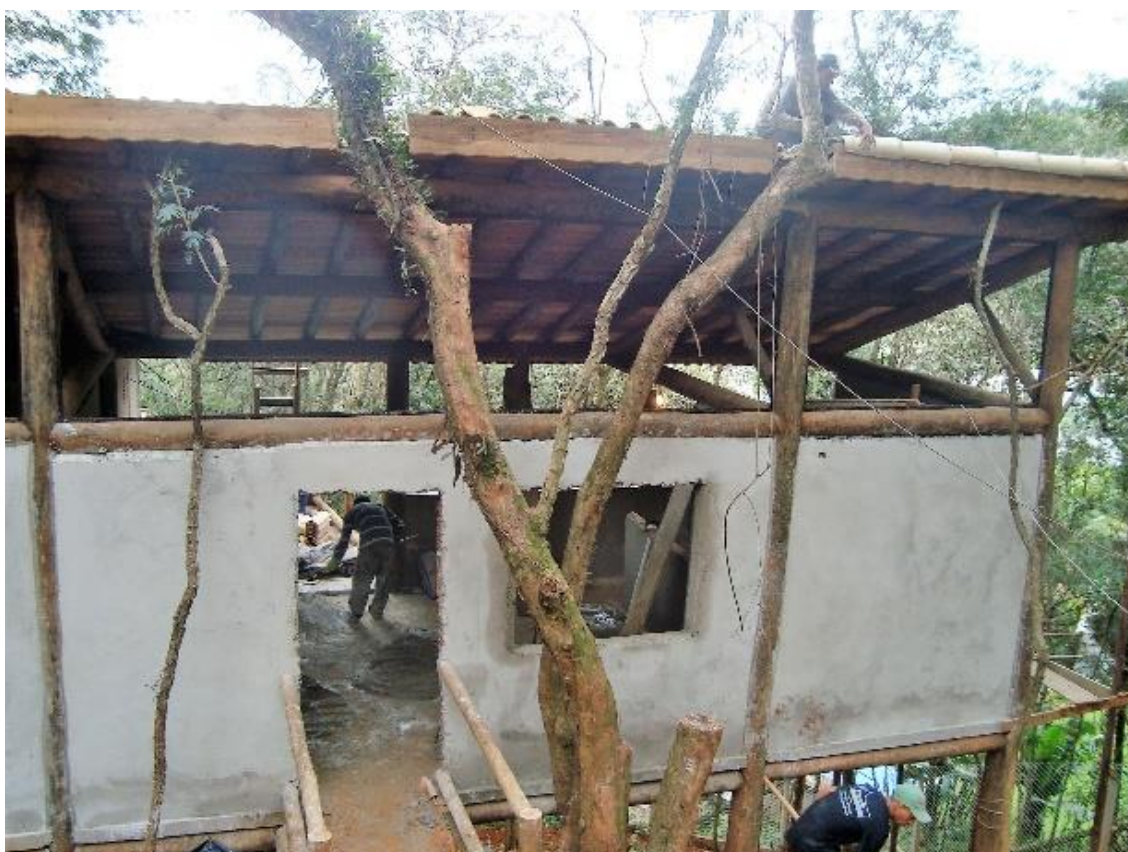
C: Reboco sendo executado
