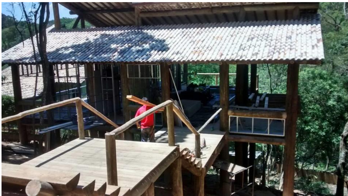
D: Vista frontal da estrutura pilar-viga de eucalyptus pronta, início da instalação dos perfis de alumínio (outubro de 2013)
