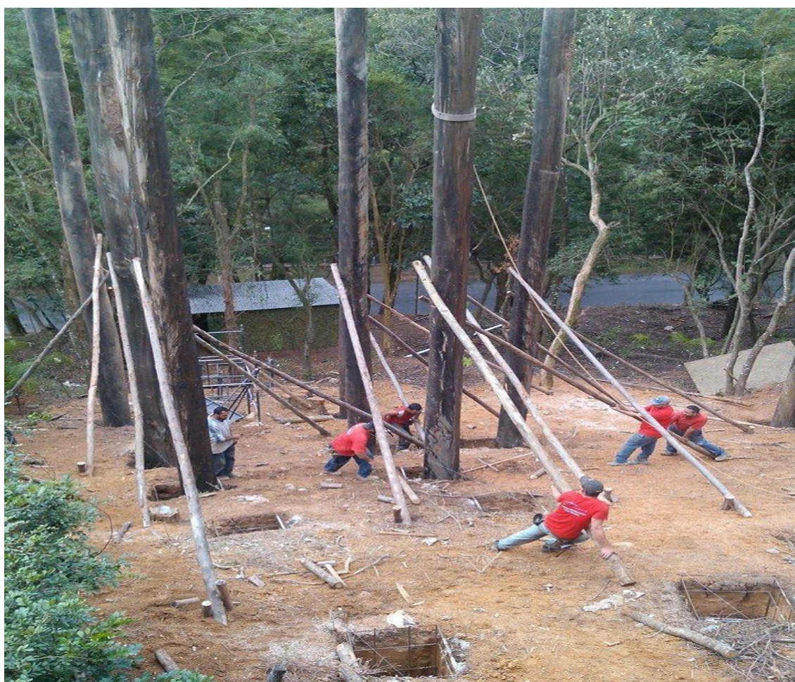
A: Estrutura em execução, pilares sendo fixados (julho de 2013)
