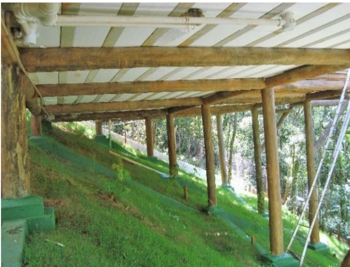
D: Vista inferior da laje pronta sobre as vigas de madeira (janeiro de 2010)
