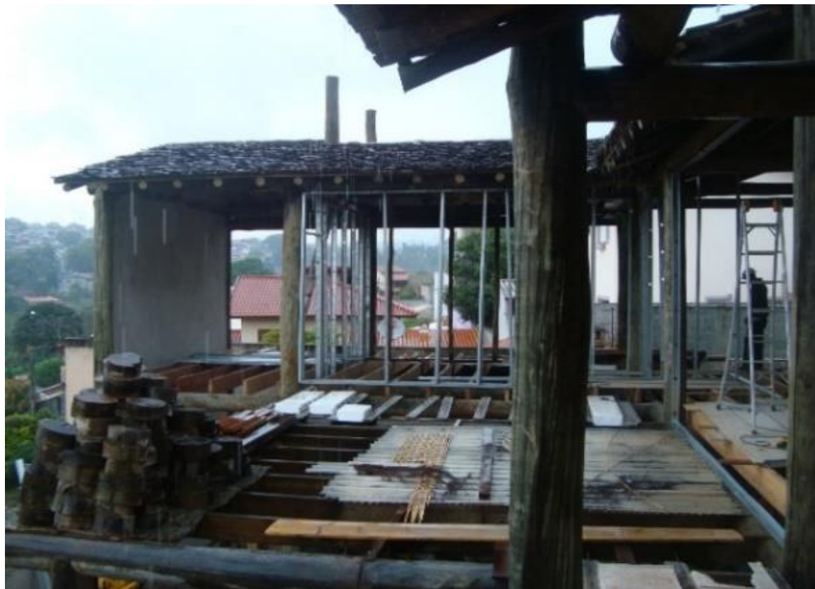
A: estrutura pilar-viga em madeira x steel frame
