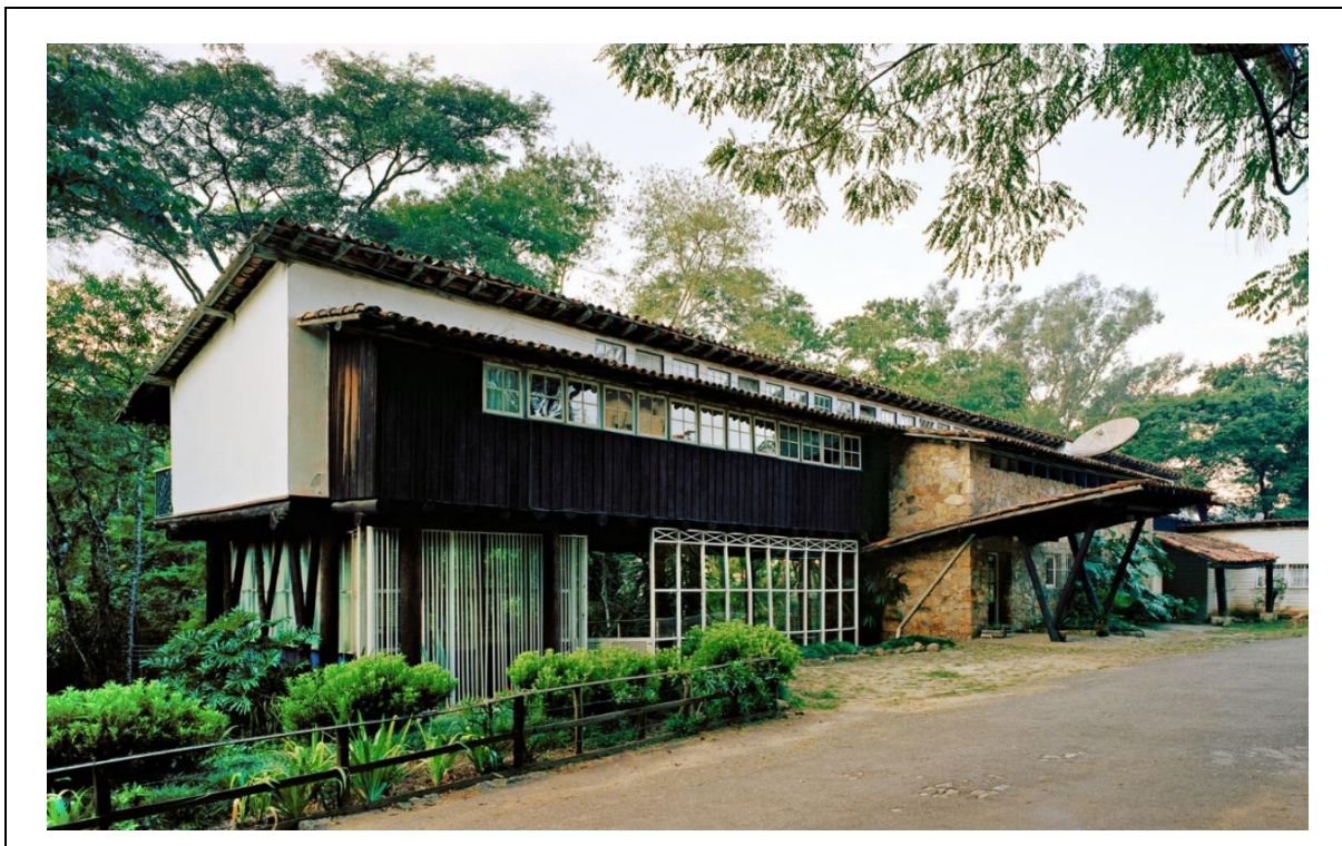
Figura 3 - Park Hotel Nova Friburgo – RJ, arquiteto Lúcio Costa, 1944 a.
