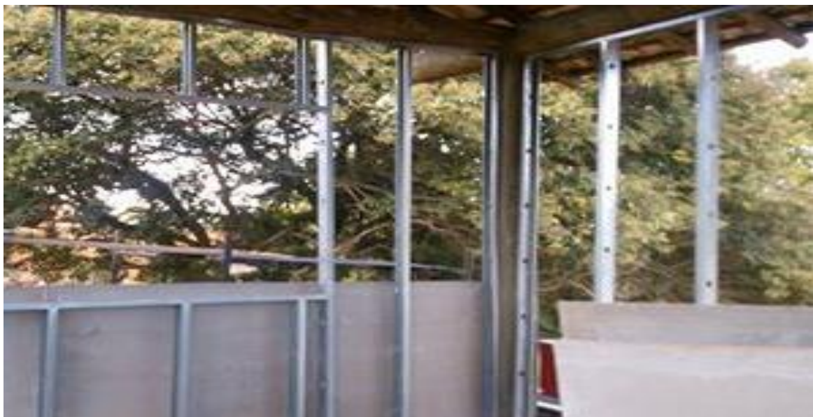
A: estrutura pilar x viga em madeira e instalação dos quadros modulares de steel frame com colocação das placas cimentícias das paredes externas
