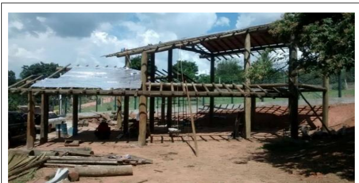
Figura 41 - Edificação residência F (a).
