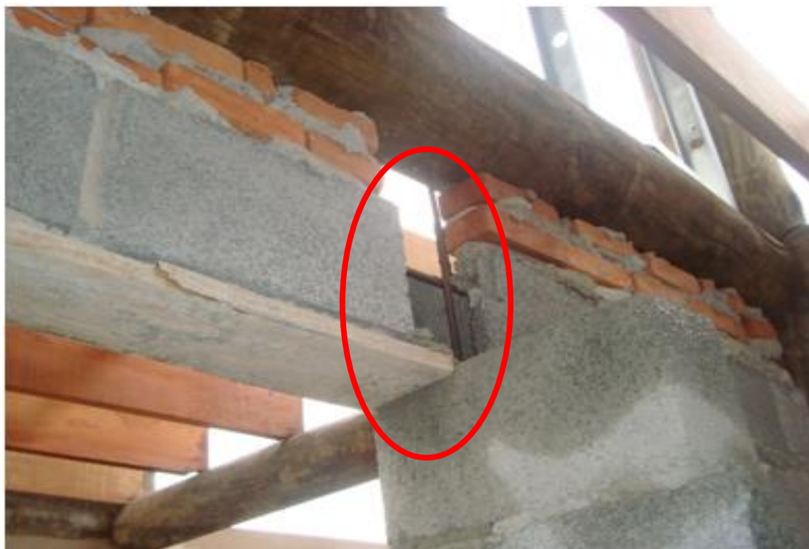
F: blocos de concreto com barras de aço 3/8", executando grautes de reforço em paredes de grandes vãos
