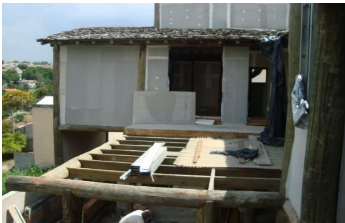
C: paredes de placas cimentícias externamente
