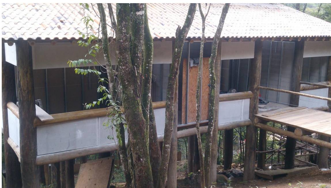
G: Finalizando vedações do sistema steel frame em estrutura pilar-viga de eucalyptus (outubro, 2013)
