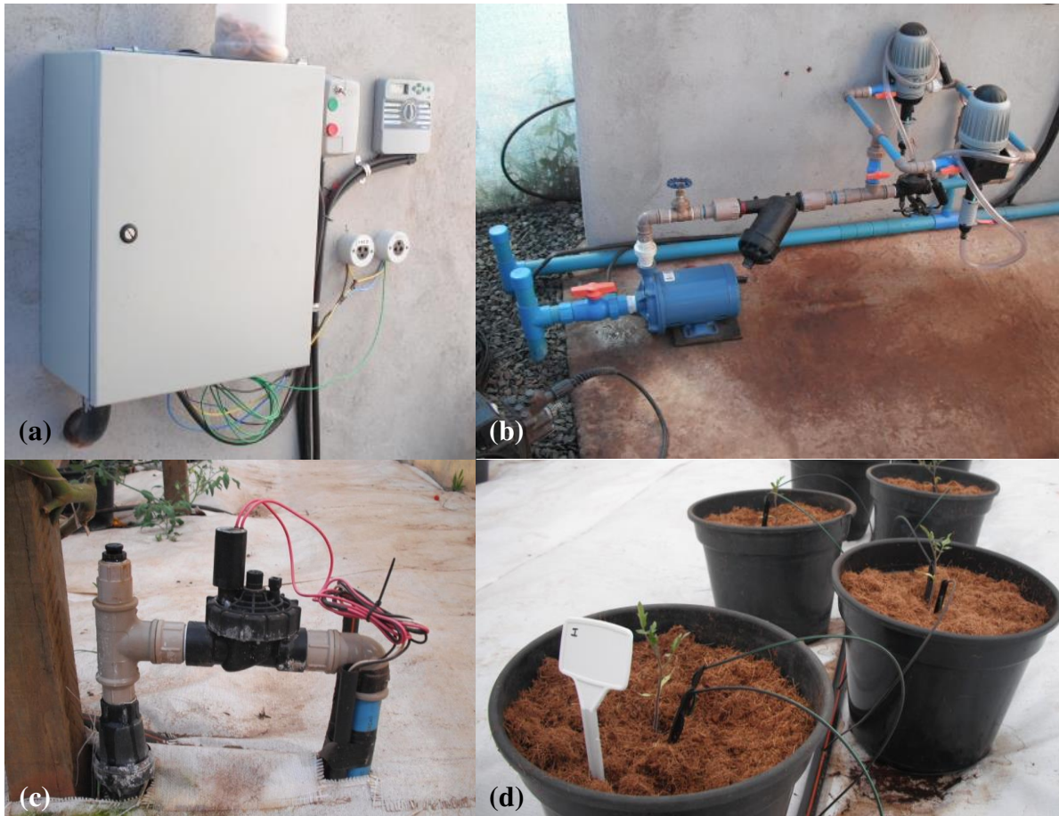
Figura 9: Elementos constituintes do sistema de fertirrigação: sistema de controle e automação (a); bomba hidráulica e bombas injetoras (b); válvula solenoide (c) e microtubos de gotejamento (d).
