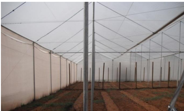
Figura 1: Vista interna da estrutura denominada tenso-estrutura.
