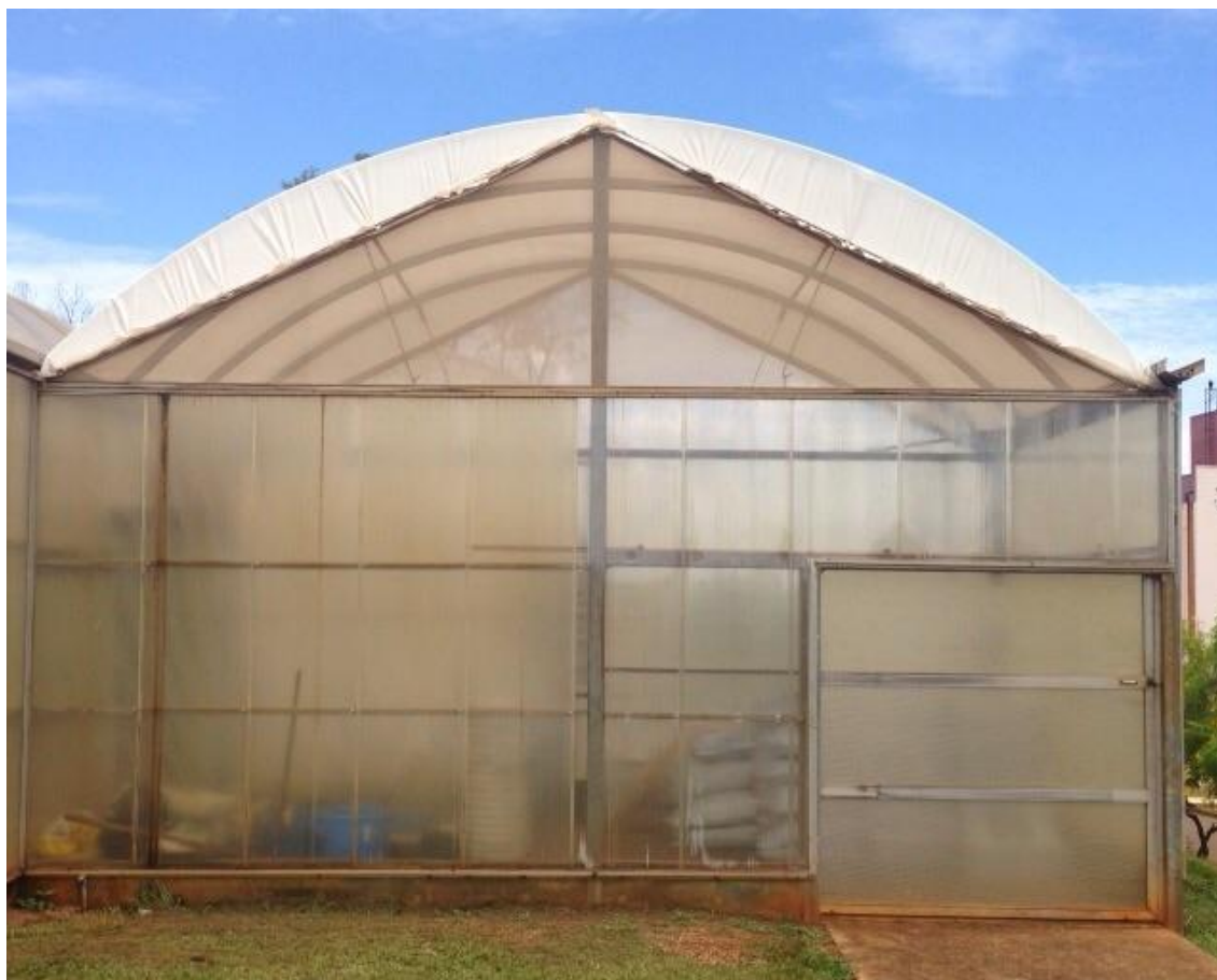
Figura 12. Estufa em arco com pórtico frontal enrijecido com diagonais. Fonte: Autor.
