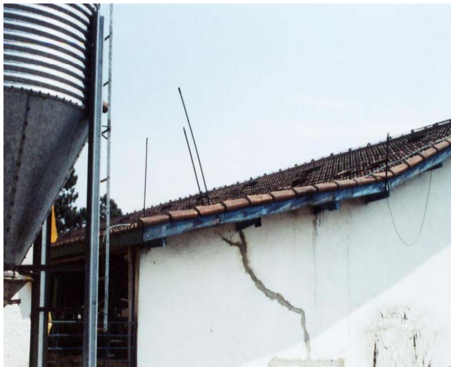
Figura 23 - Disposição final das instalações dos Rádios instalados no telhado do galpão da creche.
