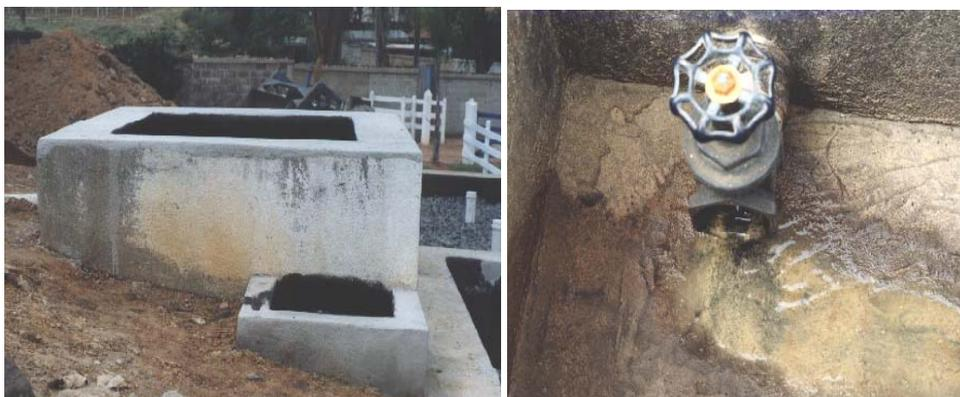
**Figura 9.** Foto ilustrativa do tanque de equalização e do registro para regulagem da vazão.
