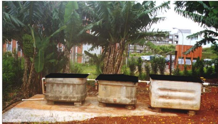
**Figura 6.** Tanque séptico modificado da FEAGRI - UNICAMP.
