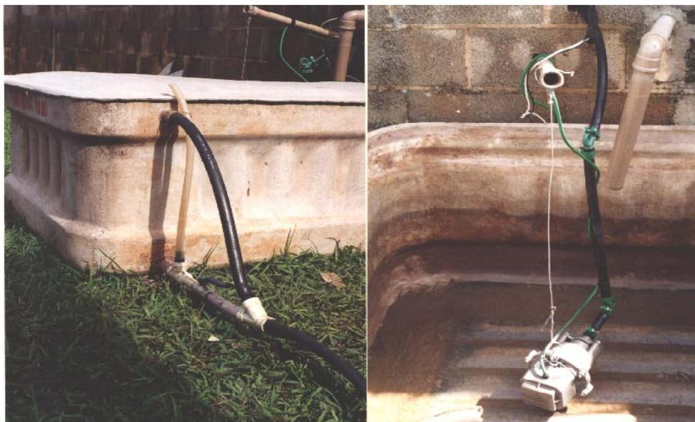
**Figura 16.** Ilustração fotográfica da caixa para armazenar o efluente do leito 2 e a bomba de fundo.
