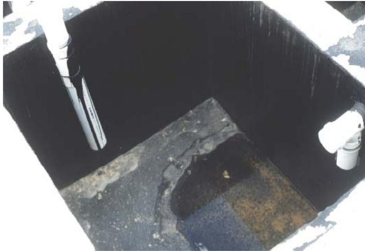
**Figura 11.** Ilustração fotográfica da alimentação dos compartimentos
