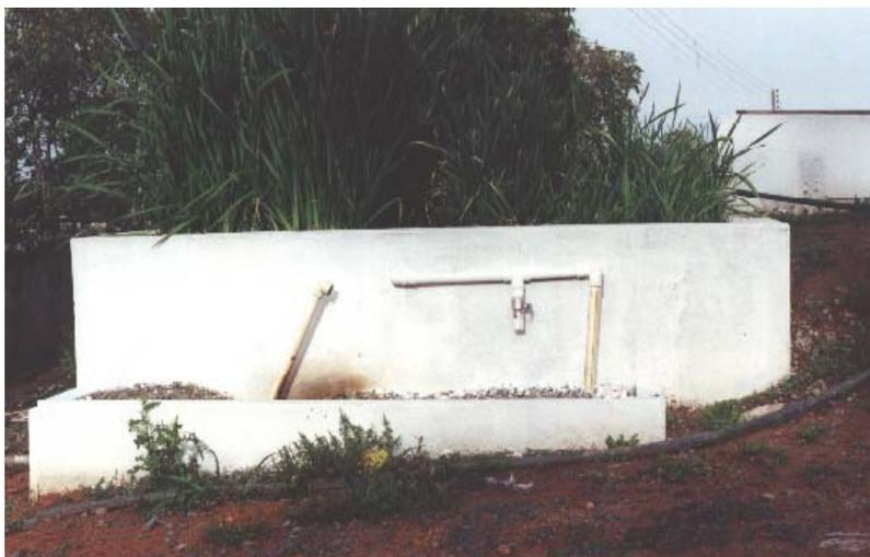
**Figura 13.** Ilustração fotográfica do sistema de regulagem da lâmina d'água.
