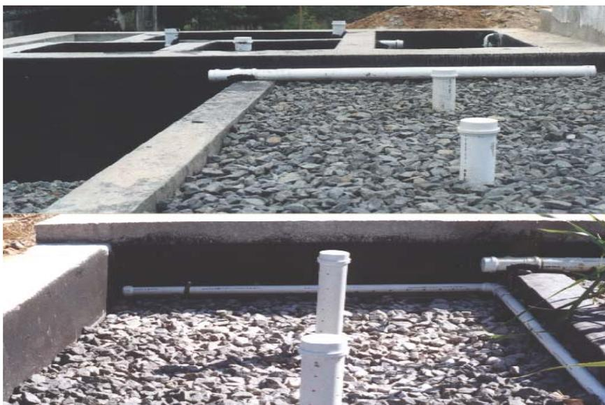
**Figura 12.** Ilustração fotográfica do efluente dos reatores e distribuição nos leitos 1 e 2.
