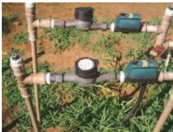
Figura 10. Foto dos Hidrômetros
