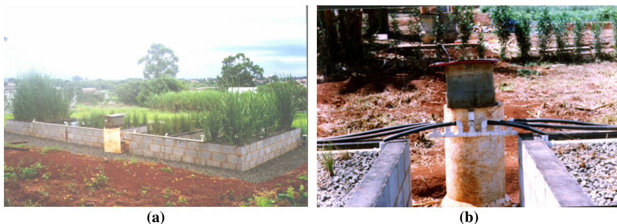
Figura 10. Divisor de vazão com a atual configuração (a) e configuração antiga (b).
