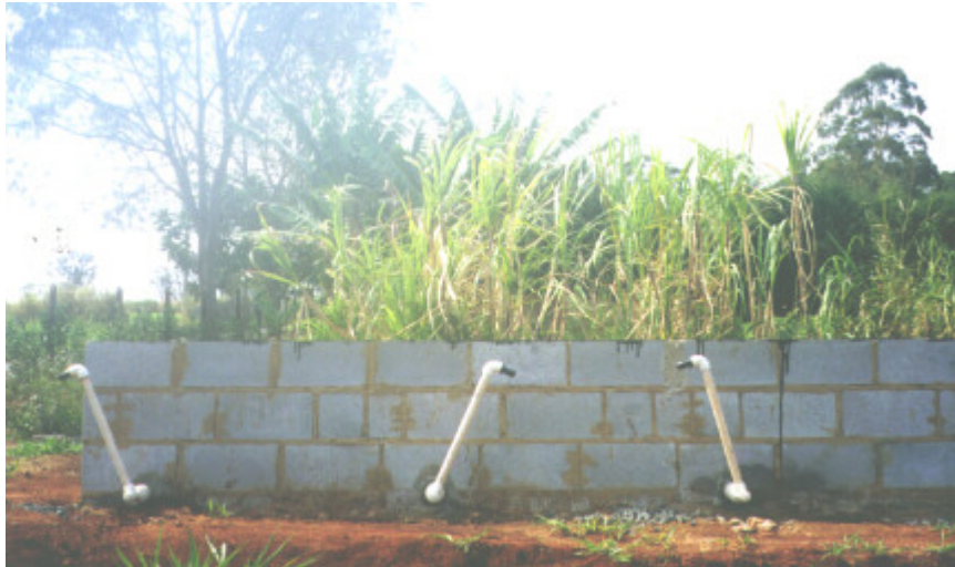
Figura 13. Regulador da lâmina d'água dos leitos cultivados
