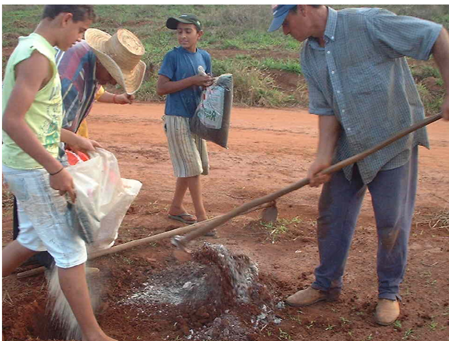
Figura 8. Preparo de argamassa para reforma da Escola
