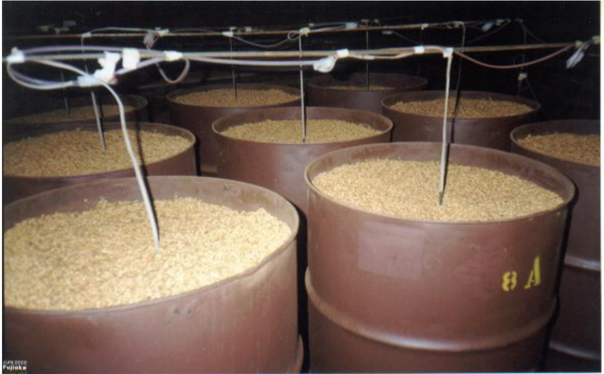
Figura 6. Vista da parte superior do sistema de termometria dos silos de armazenagem
