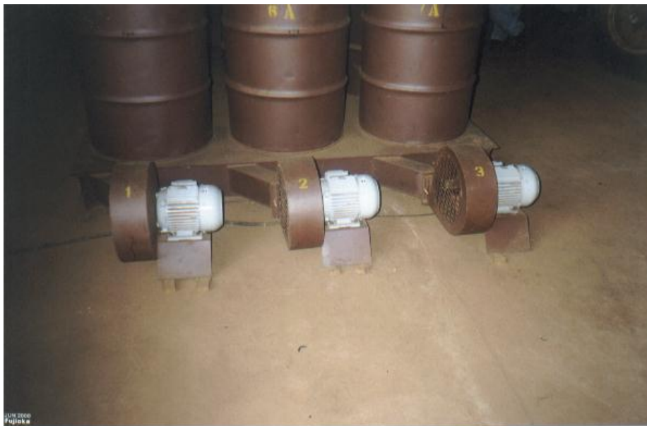
Figura 4. Vista dos silos de armazenagem com sistema de aeração
