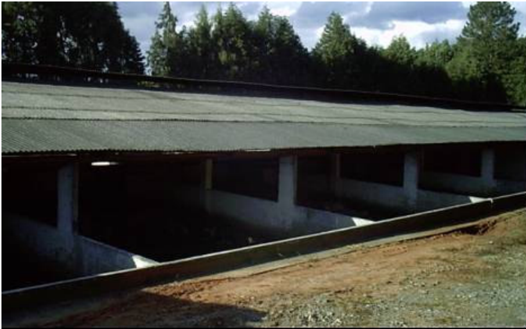
Figura 1. Vista lateral do Galpão A.
