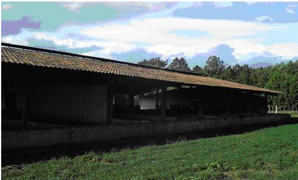
Figura 8. Vista lateral do Galpão B.
