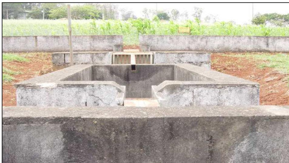
**Figura 2.** Detalhe dos tanques coletores do Campo Experimental da FEAGRI/UNICAMP, Campinas (SP).
