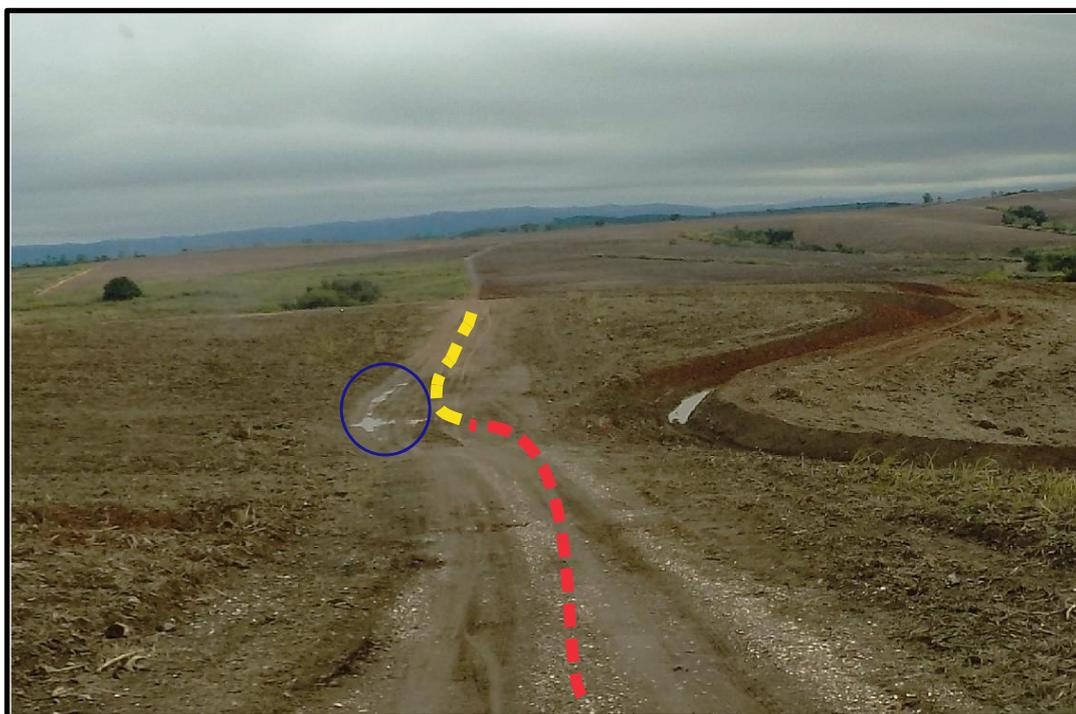
**Figura 30.** Ilustração da ocorrência de “inflexão da vertente”: em vermelho o elemento convexo e em amarelo o elemento côncavo; o círculo em azul realça a presença de água na unidade.
