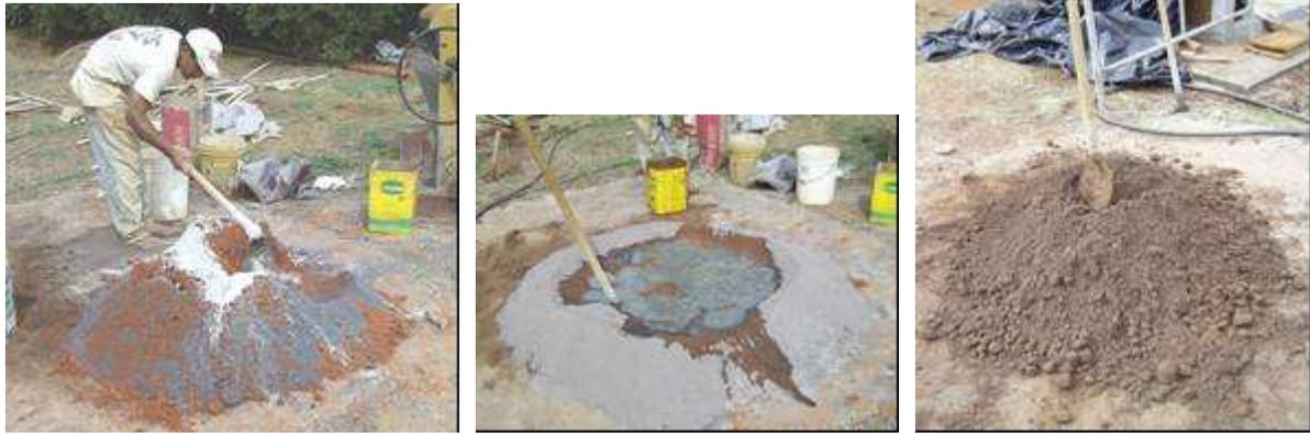
**Figura 31.** (a, b, c) Etapas para mistura manual de solo-cimento-cinza-água.
