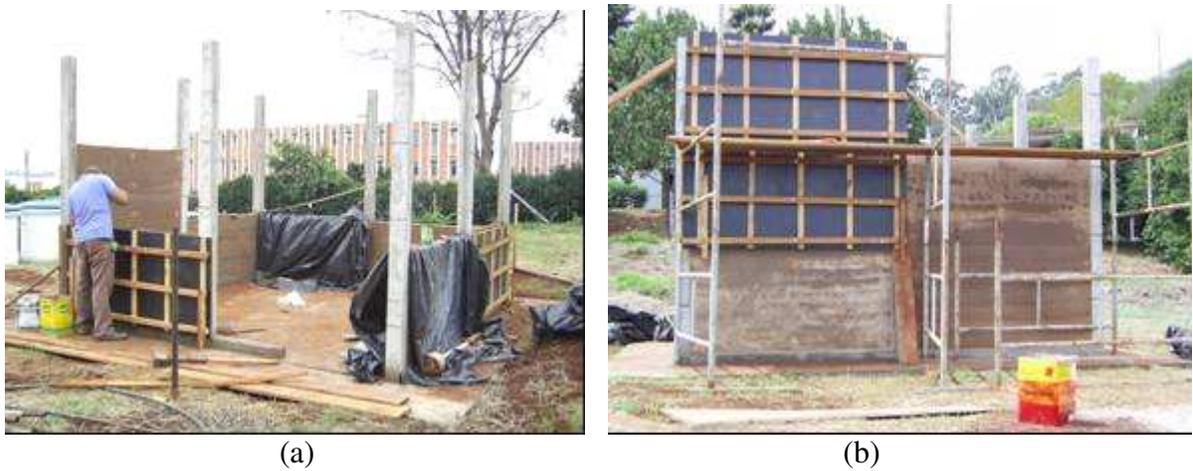
**Figura 33.** (a) Cura das paredes, (b) evolução do levantamento das paredes monolíticas.
