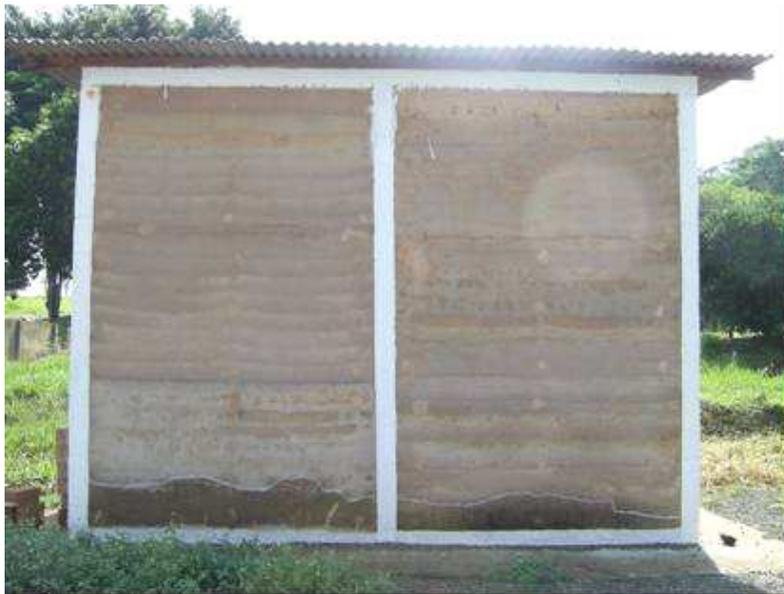
**Figura 89.** Manchas de bolor na edificação-protótipo –fachada oeste.
