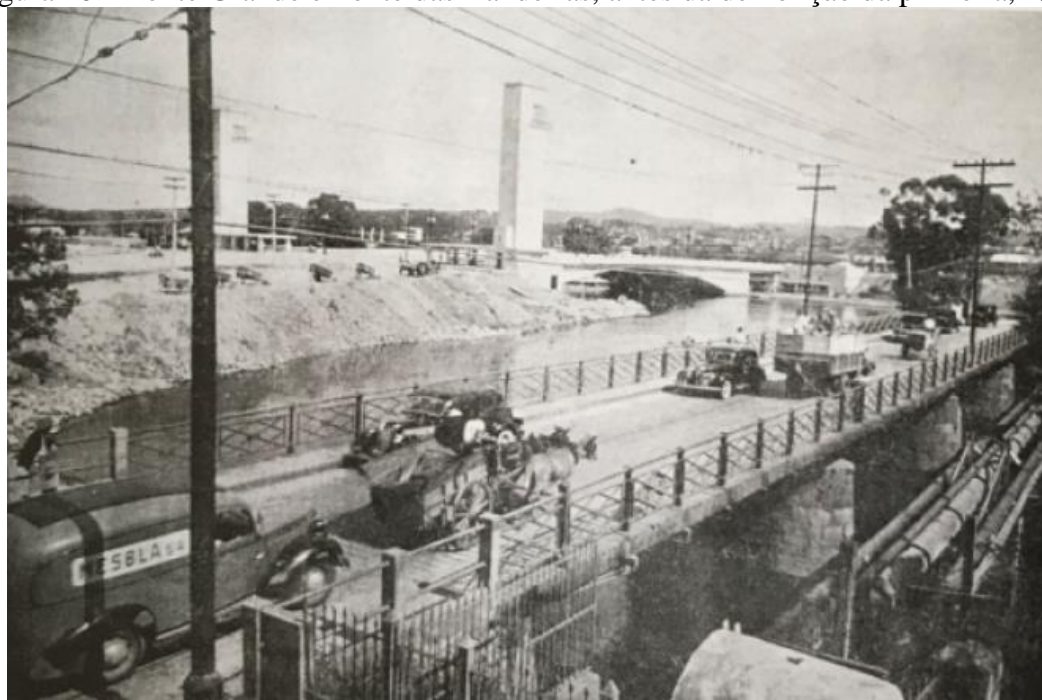
Figura 40 – Ponte Grande e Ponte das Bandeiras, antes da demolição da primeira, 1942
