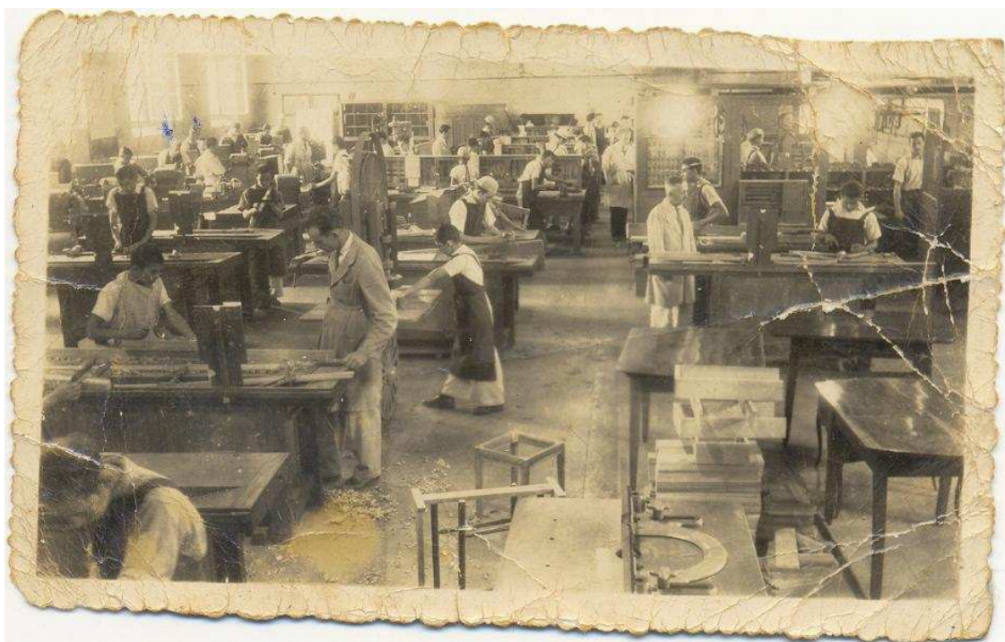
Oficina da Escola SENAI Roberto Mange, de Campinas, ainda no prédio do Externato São João, em 1947. Acervo Escola SENAI Roberto Mange.
