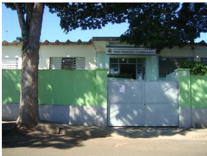
Foto 1- Vista da frente da escola
