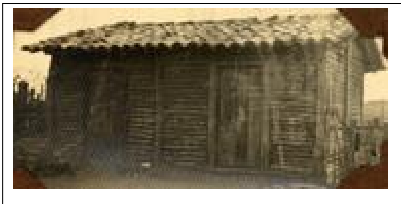
Imagem 8: Antigo prédio da Escola dos Caboçães em Sarapuí. Relatório de 1943
