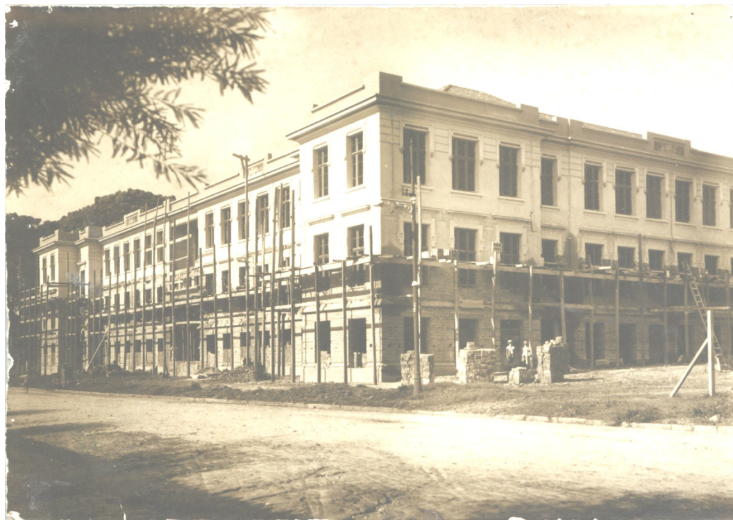
Figura 05 - Construção do novo prédio da Escola Normal de Campinas
