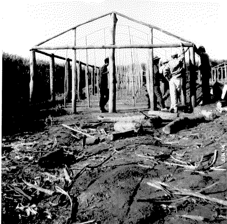
Foto 5 - CONSTRUÇÃO DA ESTUFA (para plantação de tomate e pepino)
