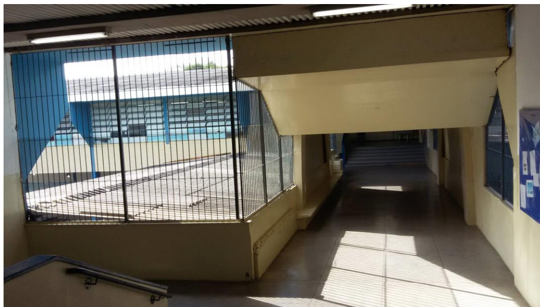
Figura 2 - Corredor de acesso às salas de aula (Escola 1)
