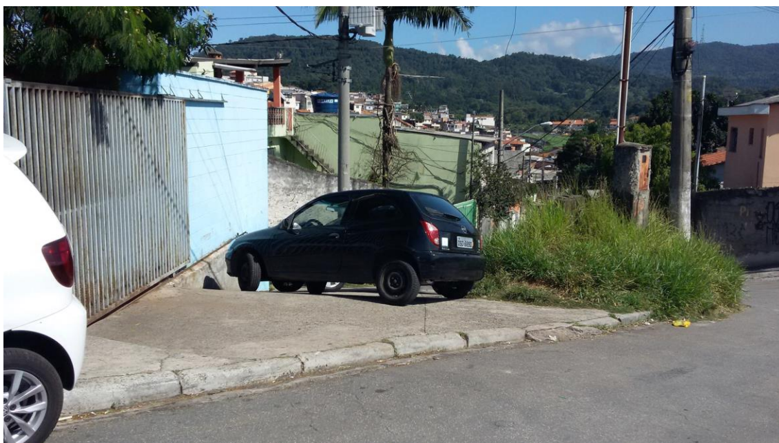
FIGURA 28 - Muro da secretaria onde vários meninos pulavam para acessar a escola
