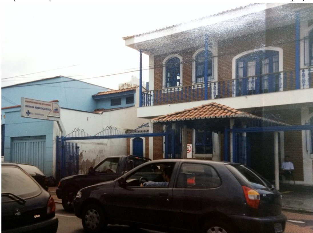
Figura 14: fachada do edifício do Centro de Reabilitação Física (Avenida Orozimbo Maia) (Fonte: Arquivo de documentos e memórias do Centro de Referência em Reabilitação)
