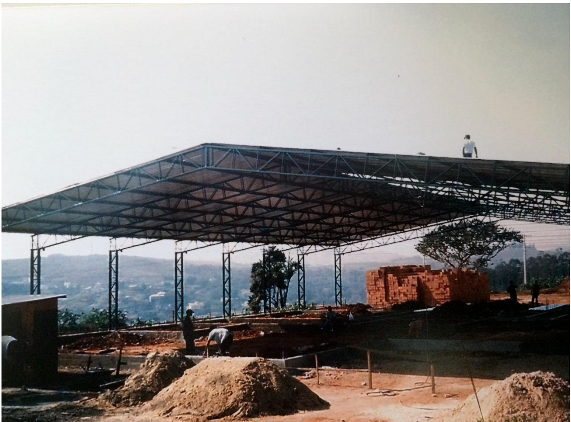
Figura 18: Obras do edifício que atualmente abriga o CRR (Fonte: Arquivo de documentos e memórias do Centro de Referência em Reabilitação)
