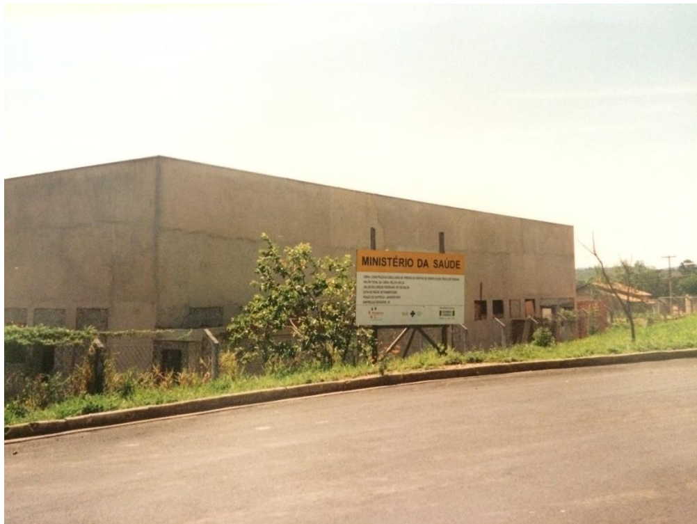
Figura 22: Continuação das obras do edifício do Centro de Referência em Reabilitação (Fonte: Arquivo de documentos e memórias do Centro de Referência em Reabilitação)
