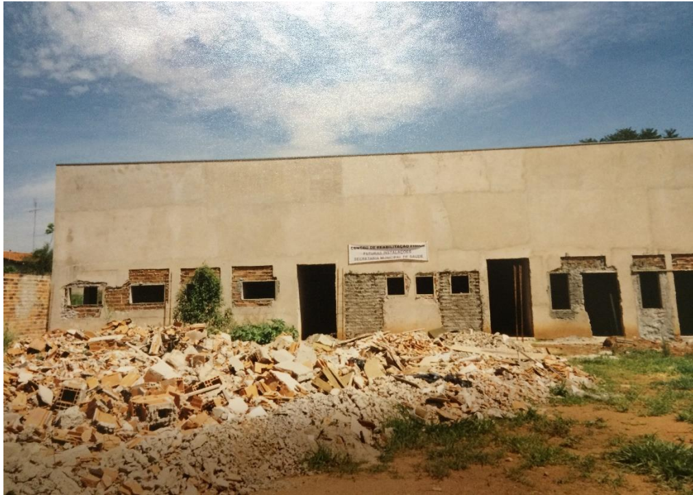
Figura 21: Continuação das obras do edifício do Centro de Referência em Reabilitação (Fonte: Arquivo de documentos e memórias do Centro de Referência em Reabilitação)
