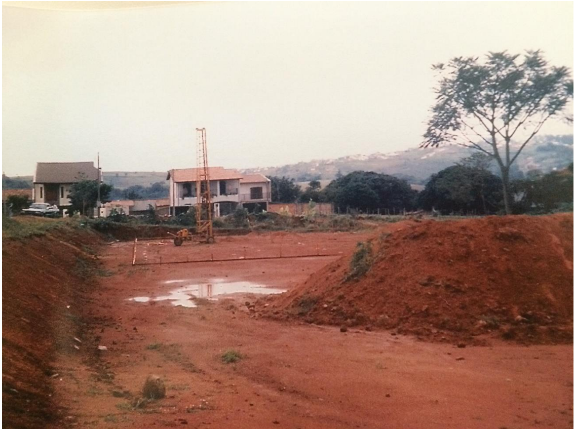
Figura 17: Início das obras do edifício que atualmente abriga o CRR. (Fonte: Arquivo de documentos e memórias do Centro de Referência em Reabilitação)
