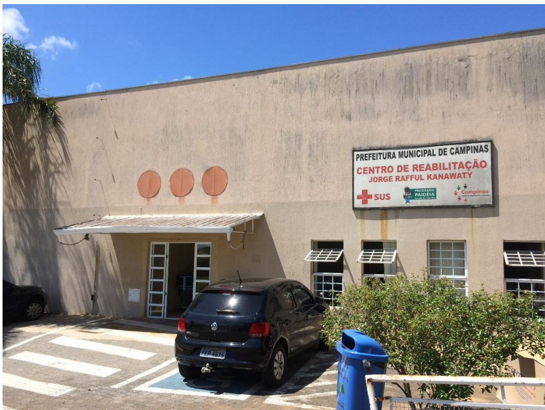
Figura 26: Fachada atual do Centro de Referência em Reabilitação (2016) (Fonte: arquivo pessoal do pesquisador)
