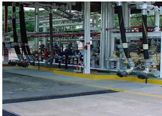
**Figura 8: Carregamento *bottom loading***
