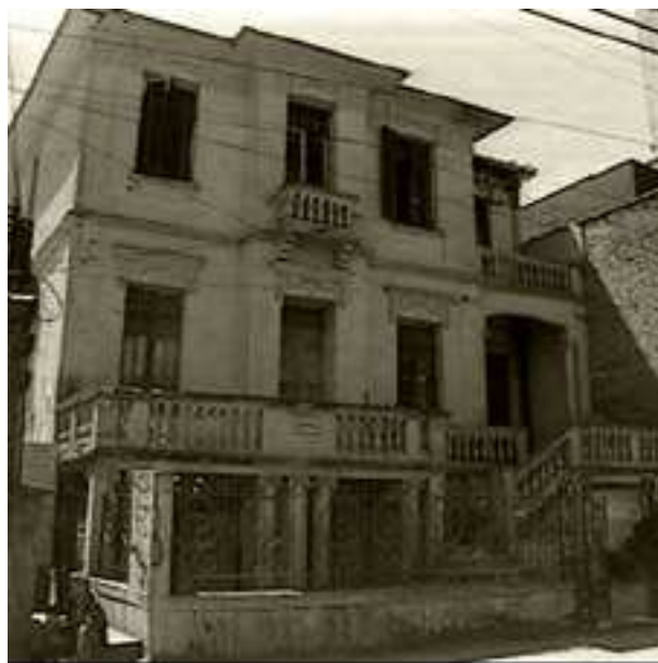
Figura 05 – Foto do Edifício do Casarão.
