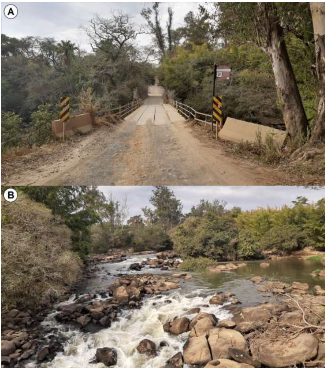
Figura 13: A) Ponte sobre o Rio Atibaia, região do bairro Carlos Gomes; B) Local de ocorrência de matacões nas margens do rio. Acesso facilitado por trilhas.
