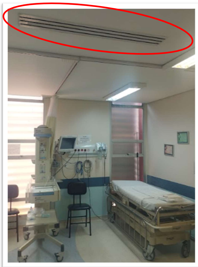
Figura 23. Em destaque, a grelha de saída do ar condicionado na sala de RPA. Foto e intervenção: autor.
