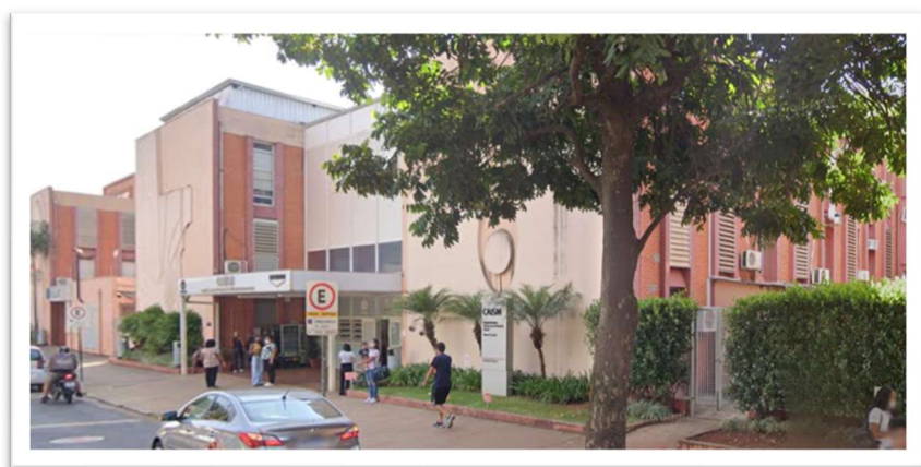
Figura 14: CAISM – recepção principal. Fonte: Google Earth, 2023.
