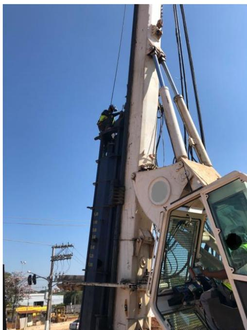
Figura 16 - Terceirizado escala máquina sem EPIs. Foto própria, 2020.
