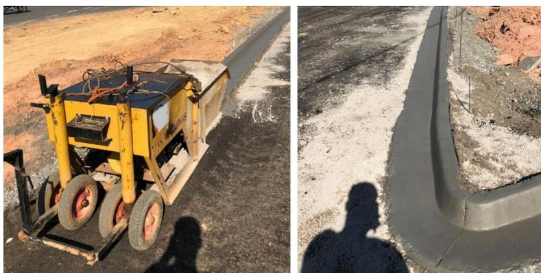
Figuras 11 e 12: Máquina extrusora de guia (esq.). Guia finalizada (dir.) Fotos próprias, 2020.
