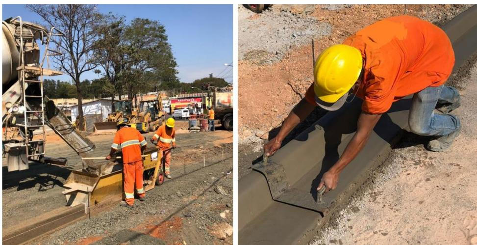
Figuras 14 e 15: Máquina extrusora operando (esq.). Finalização da guia (dir.) Fotos próprias, 2020.
