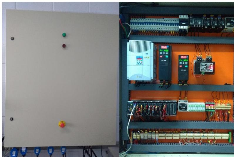
Para o painel eletrônico novo trocou-se o CLP utilizado anteriormente por um mais moderno, que possui mais cartões de entradas e saídas analógicas, comunicação Ethernet e uma maior capacidade de memória e processamento. Trocou-se o inversor de frequência utilizado anteriormente para o controle de velocidade do compressor por um inversor de maior capacidade, pois o anterior apresentou problemas na corrente de partida em algumas ocasiões.
