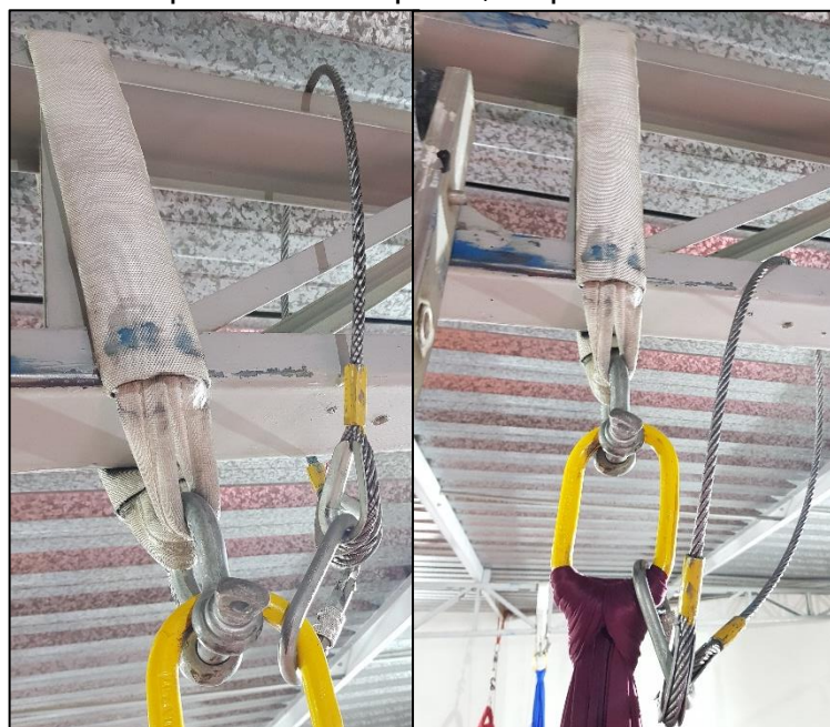
Figura 6 - Exemplos de ancoragens de tecido acrobático com backups adequado e inadequado, respetivamente.
