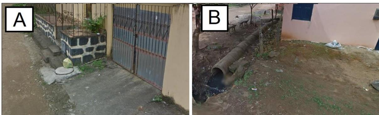
**Figura 11** - A) Estrutura de fossa séptica em Salobrinho, Ilhéus; B) Obra de captação de esgoto interrompida em Floresta Azul. Fonte: Atividade de campo em 02/2019.
