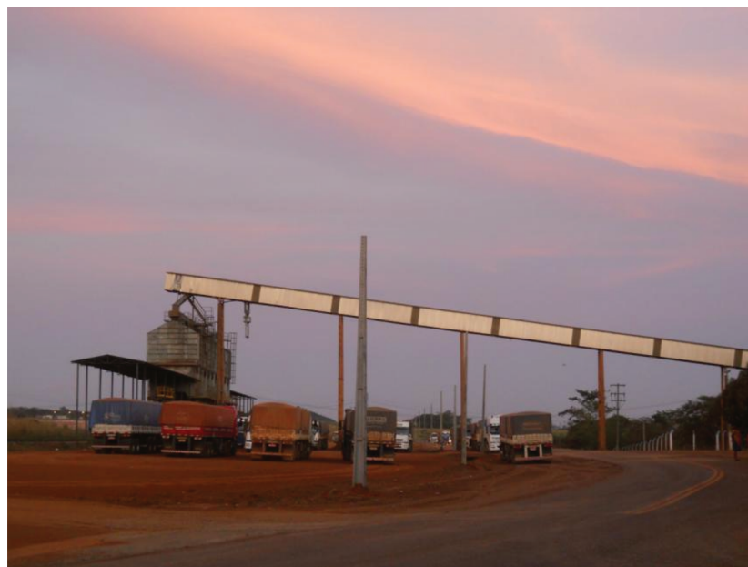
Foto 2.5 Área de carregamento intermodal de Porto Franco (MA)
