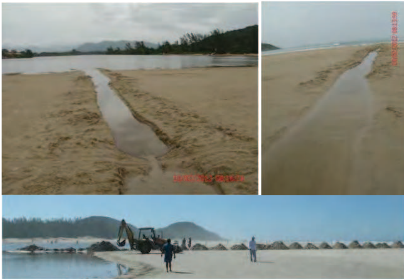
Figura 33: Tentativa de abertura ilegal (fotos acima) e abertura autorizada (foto abaixo) da Barra da Lagoa de Ipiraquera pelo Comitê Gestor de Abertura da Barra da Lagoa de Ipiraquera. Fotos: Acervo APA-BF.
