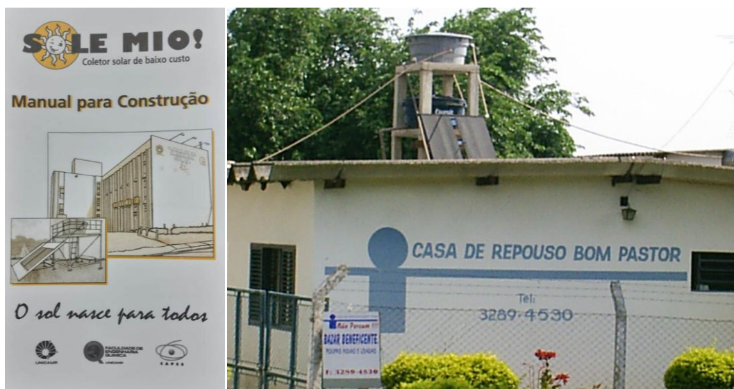
Figura 7: a) Manual para construção de Coletor Solar de Baixo Custo. b) Sistema CSBC e reservatórios montados em casa de repouso na região de Campinas
