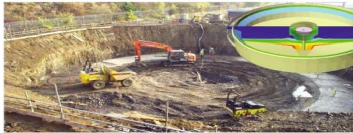
Figura 10 – Construção de um novo tanque em uma usina de tratamento de água. A figura do lado direito superior descreve a simulação de CFD do tanque de água que será instalado dentro do local escavado.
