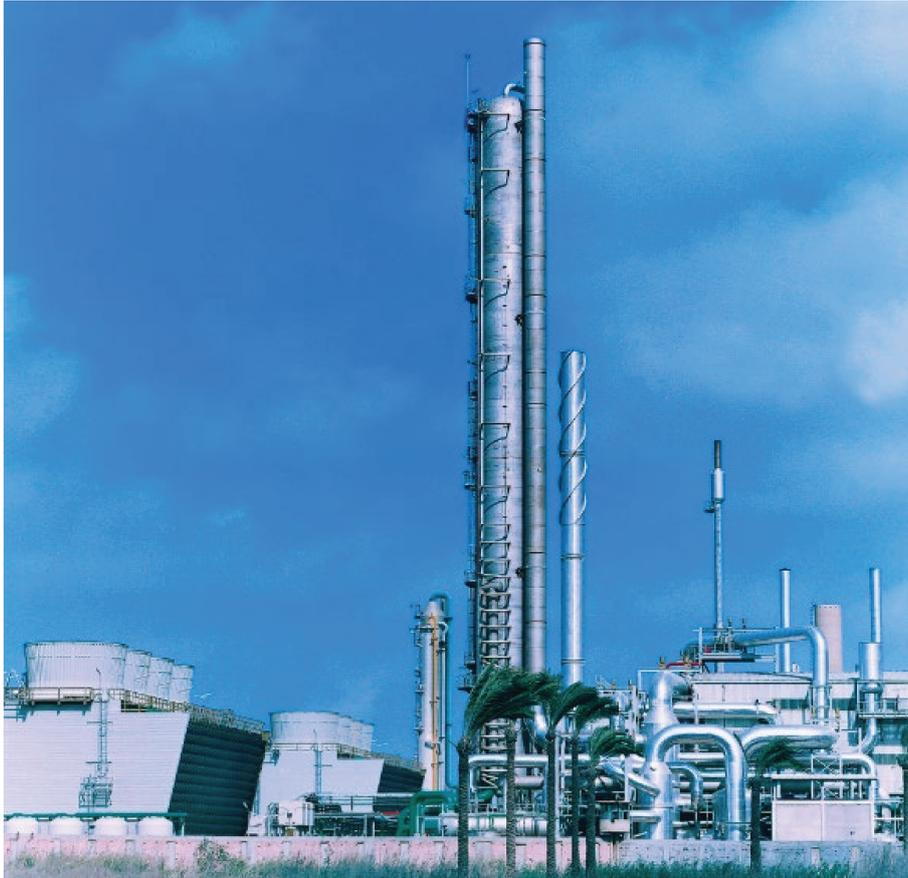
**Figura 2.7: Unidade industrial de produção de ácido nítrico com sistema de absorção para gases nitrosos. Com refrigeração individual por prato –Fonte: Thyssen Krup.**
