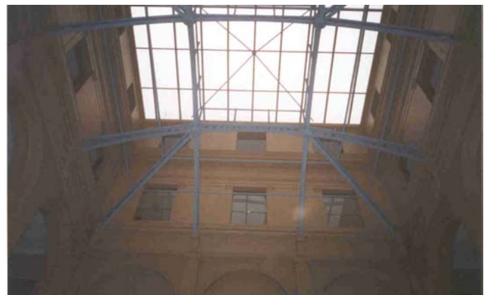
Foto 9: Estrutura da cobertura original e cobertura atual de vidro e ferro. Vistas de baixo
