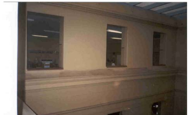
Foto 6: Saguão Central – vista para o Setor de Engenharia e Arquitetura
