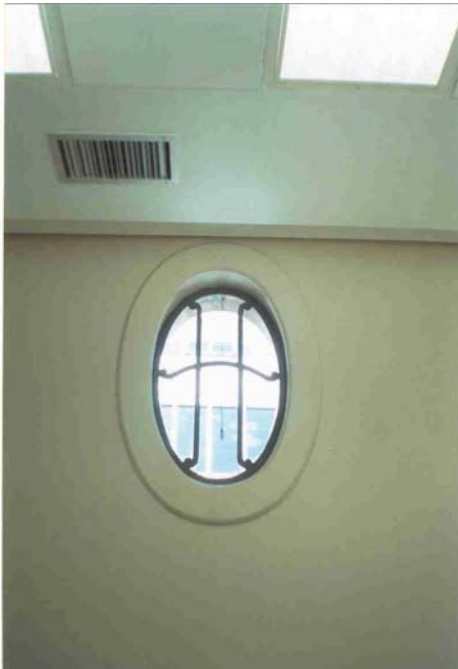
Foto 4: Tipo de esquadria existente na fachada sul, do quarto pavimento
