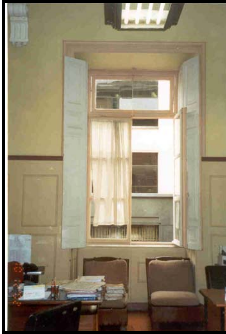
Figura 16- Tipologia de esquadria do 1º pavimento do edifício 184, fachada oeste;
