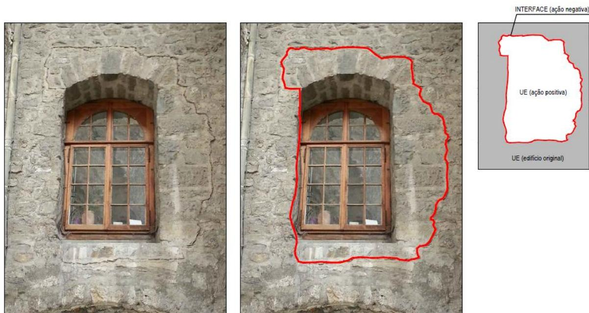
FIGURA 19 “Unidade Estratigráfica” positiva: construção de uma nova janela. “Interface de remoção”: ação negativa referente à remoção da porção de alvenaria original. Foto da autora, 2014.
