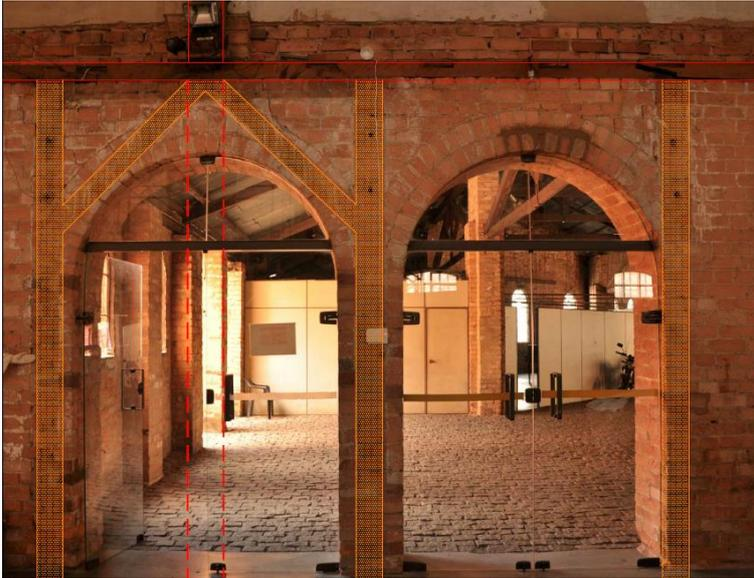
FIGURA 110 (à esquerda) Esquema do sub-sistema estrutura do telhado: quando as aberturas coincidiam com os módulos dos pilares em madeira, os esforços eram direcionados para as laterais, conforme indicado em laranja na fotografia. Foto da autora, 2015.
