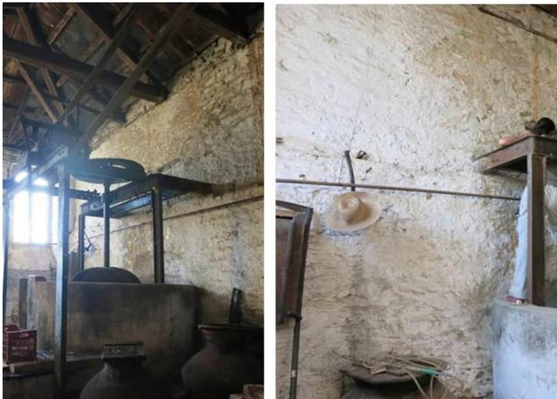
FIGURA 88A Parte interna da parede que desmoronou provavelmente por conta de um terremoto e que foi reconstruída posteriormente. FIGURA 88B Detalhe da fissura que indica o trecho remanescente da parede original e aquela que desabou. Fotos: Waeovichian Abhichtvorapan, 2013.
