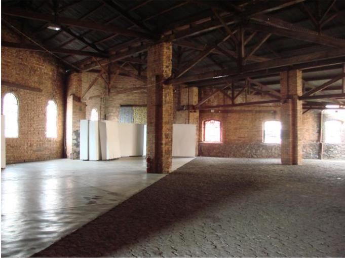
FIGURA 102 Vista do galpão secundário, onde funcionava a fundição. As paredes divisórias, assim como no galpão principal, também foram removidas, restando apenas os pilares de sustentação da cobertura. Foto da autora, 2015.
