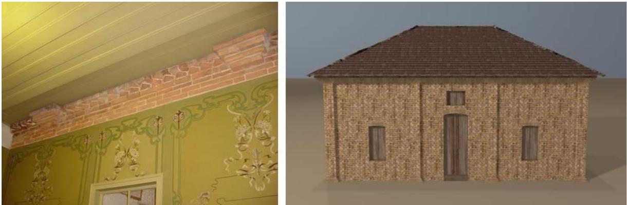
FIGURA 61A A antiga cimalha de tijolos descoberta após a remoção do forro interno de madeira. A parede correspondia à antiga fachada principal do chalet. FIGURA 61B Reconstituição computacional do antigo chalet de tijolos a partir dos indícios da antiga estrutura. Fonte: Arquivo Regina Tirello / CPC-USP 2005.
