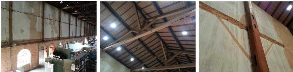
FIGURA 109 Estrutura do telhado no galpão principal. Após as obras de reforma do prédio, parte da estrutura de madeira que sustentava o piso e o forro foi removida, remanescendo apenas marcas sobre as paredes e os encaixes das peças. Fotos da autora, 2015.
