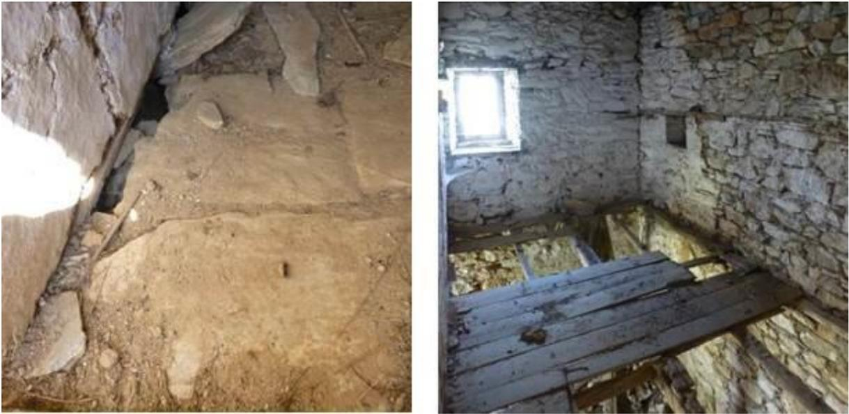
FIGURA 71 Interior do lagar. Figura 71A Piso térreo em terra batida Figura 71B Mezanino com estrutura e assoalho em madeira. Fonte: Seminário Diadrasis, 2013.
